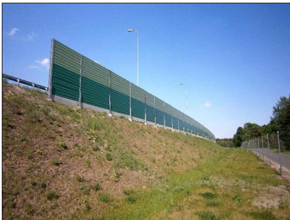
Zdj. Przykład realizacji ekranów akustycznych (Autostrada A1 148+850)
