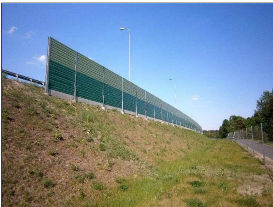
Zdj. Przykład realizacji ekranów akustycznych (Autostrada A1 148+850)
