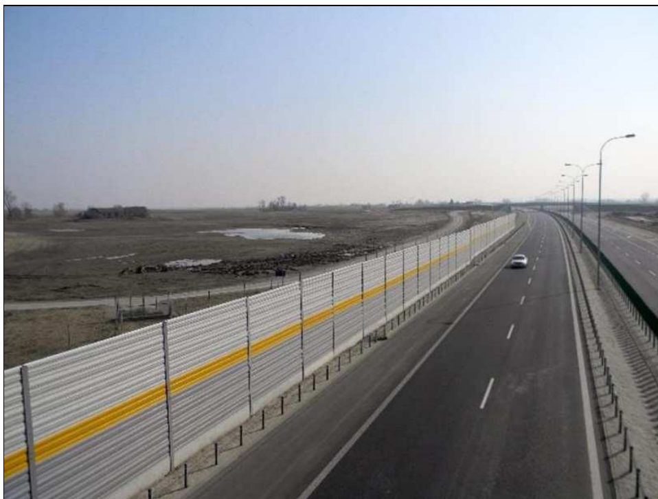
Zdj. Przykład realizacji ekranów akustycznych (Autostrada A1 112+550)
