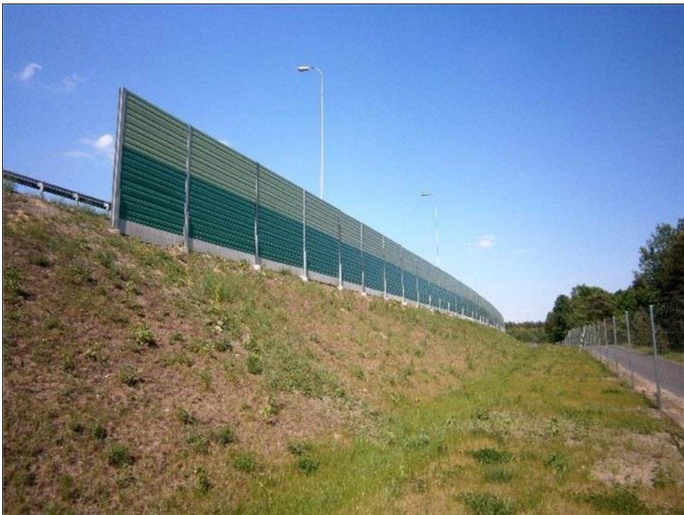
Zdj. Przykład realizacji ekranów akustycznych (Autostrada A1 148+850)
