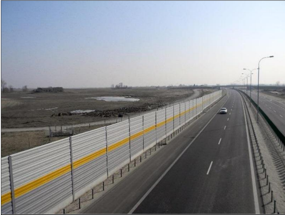
Zdj. Przykład realizacji ekranów akustycznych (Autostrada A1 112+550)
