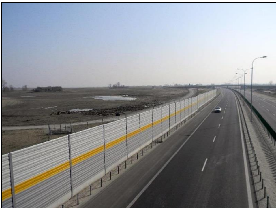
Zdj. Przykład realizacji ekranów akustycznych (Autostrada A1 112+550)
