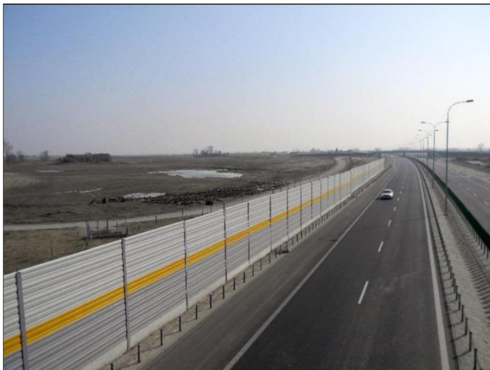
Zdj. Przykład realizacji ekranów akustycznych (Autostrada A1 112+550)
