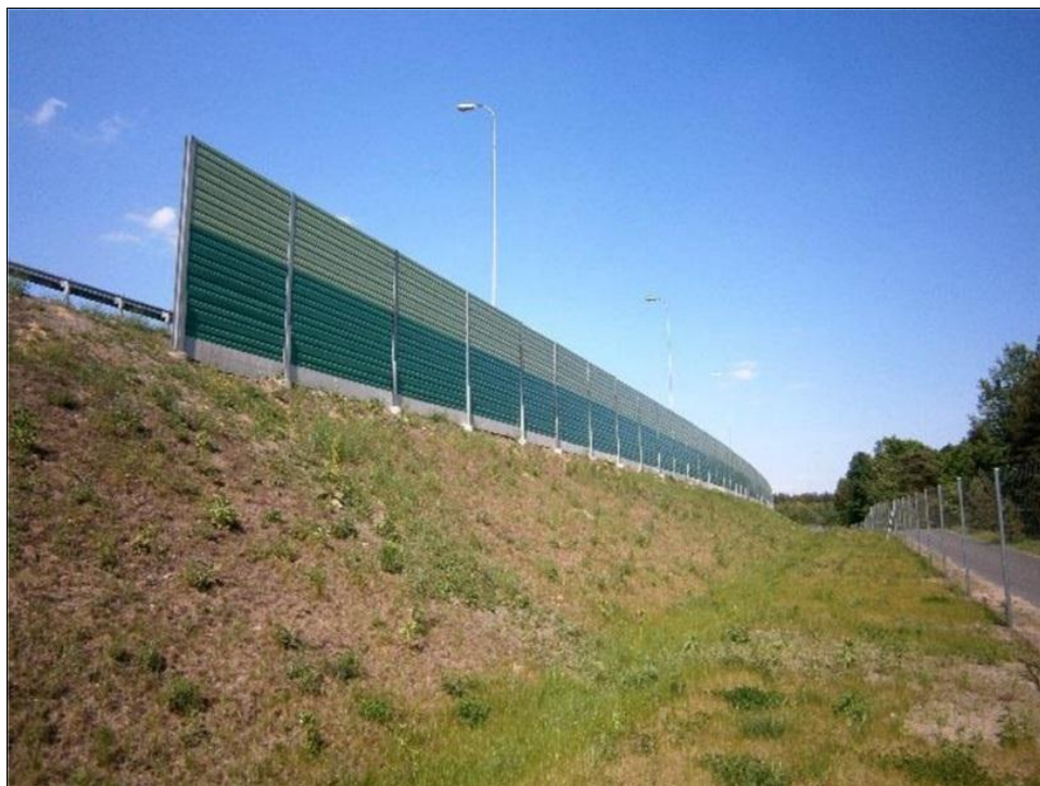
Zdj. Przykład realizacji ekranów akustycznych (Autostrada A1 148+850)
