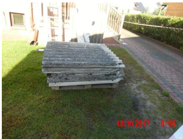
Niewłaściwy sposób składowania odpadów zawierających azbest- brak zabezpieczenia palety folią o gr. 0,2 mm, brak oznakowania odpadów, nie wyznaczono i nie oznakowano strefy niebezpiecznej dla składowanych odpadów.
