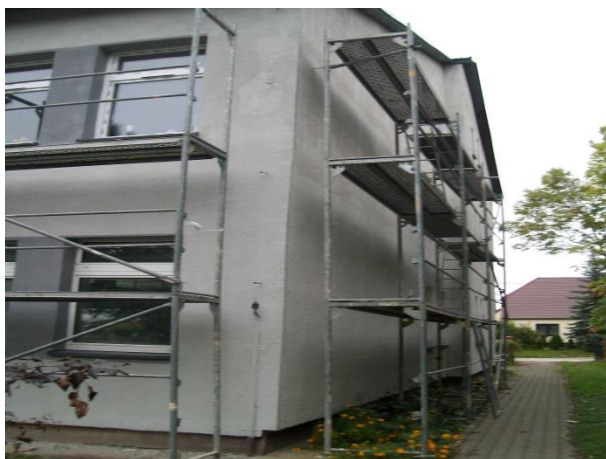
Rusztowania ramowe bez wymaganych barier ochronnych, brak wygrodenienia stref niebezpiecznych w miejscu pracy podnośnika koszowego.
