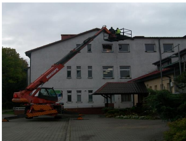
Rusztowania ramowe bez wymaganych barier ochronnych, brak wygrodenienia stref niebezpiecznych w miejscu pracy podnośnika koszowego.
