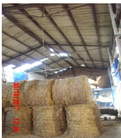
Budynek gospodarczy o powierzchni 200m 2 . Dach budynku wykonany z płyt eternitowych w bardzo złym stanie, cały dach był porośnięty mchem. Przystąpiono do demontażu płyt eternitowych z zamiarem bezpośredniego wejścia na dach po drabinie przystawnej. Ze względu na niewłaściwą organizację pracy wydano decyzję zakazującą wykonywania demontażu płyt eternitowych do czasu zapewnienia bezpiecznego sposobu wykonywania rozbiórki przy użyciu podnośnika samochodowego lub rusztowania ustawionego wewnątrz budynku.
