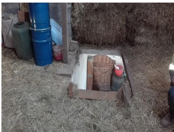
Niebezpieczony otwór stropowy
