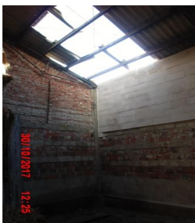
Budynek gospodarczy o powierzchni 200m 2 . Dach budynku wykonany z płyt eternitowych w bardzo złym stanie, cały dach był porośnięty mchem. Przystąpiono do demontażu płyt eternitowych z zamiarem bezpośredniego wejścia na dach po drabinie przystawnej. Ze względu na niewłaściwą organizację pracy wydano decyzję zakazującą wykonywania demontażu płyt eternitowych do czasu zapewnienia bezpiecznego sposobu wykonywania rozbiórki przy użyciu podnośnika samochodowego lub rusztowania ustawionego wewnątrz budynku.
