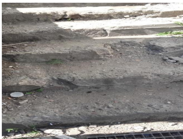
Stan magazynu – ogólny nieporządek, schody prowadzące do do pomieszczenia magazynu głównego w złym stanie technicznym
