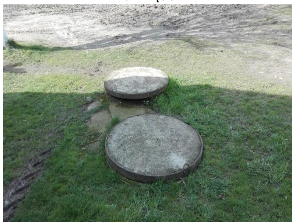
Zabezpieczone szambo podwórza
