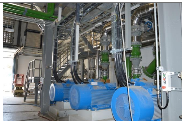
Rysunek 65 Tak jest. Spalarnia odpadów komunalnych, hala turbin, Bydgoszcz ProNatura ZTPOK (foto: Bydgoszcz, październik 2015r)
