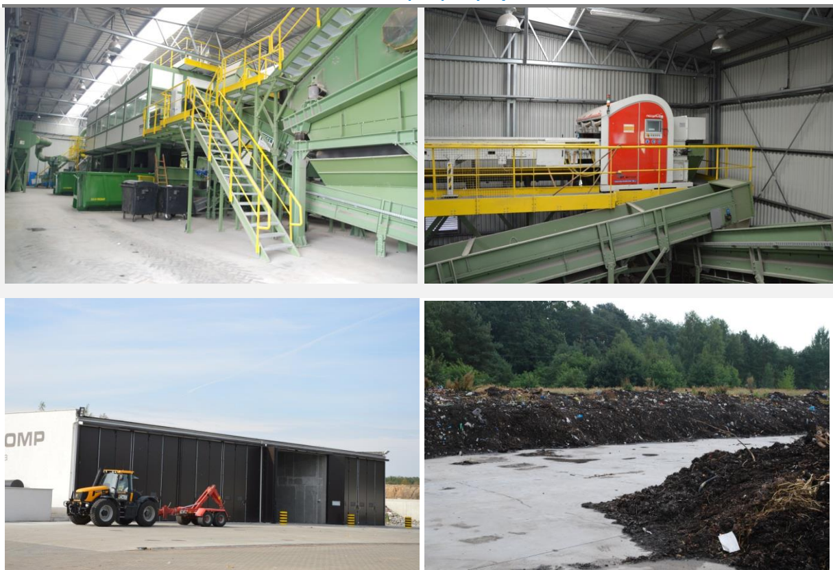
Rysunek 25 Tak jest. Nowa instalacja do biologicznego przetwarzania odpadów z możliwością kompostowania odpadów zielonych, Niedźwiedź (foto: Niedźwiedź, wrzesień 2015r).
