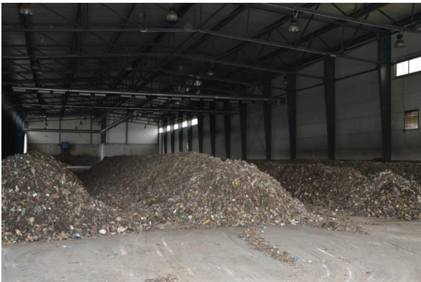
Rysunek 9 Tak jest. Nowa instalacja do biologicznego przetwarzania odpadów z możliwością kompostowania odpadów zielonych, Sulńówko (foto: Sulńówko, wrzesień 2015r).
