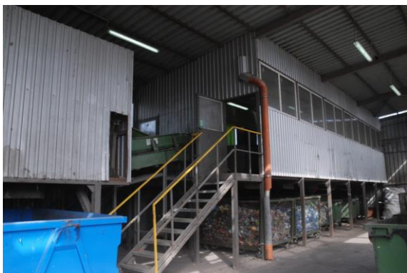
Rysunek 33 Tak było. Sortownia odpadów komunalnych, Lipno (sierpień 2013r)
