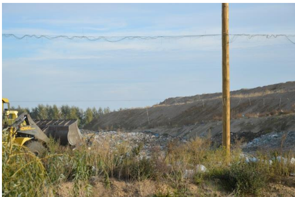
Rysunek 78 Tak jest. Składowisko odpadów, niecka nr III, Wawrzynki (foto: Wawrzynki, październik 2015r)
