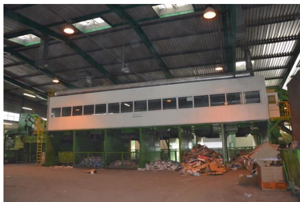
Rysunek 71 Tak jest. Sortownia odpadów komunalnych zmieszanych i selektywnie zebranych, Toruń MPO (foto: Toruń, MPO, wrzesień 2015r)
