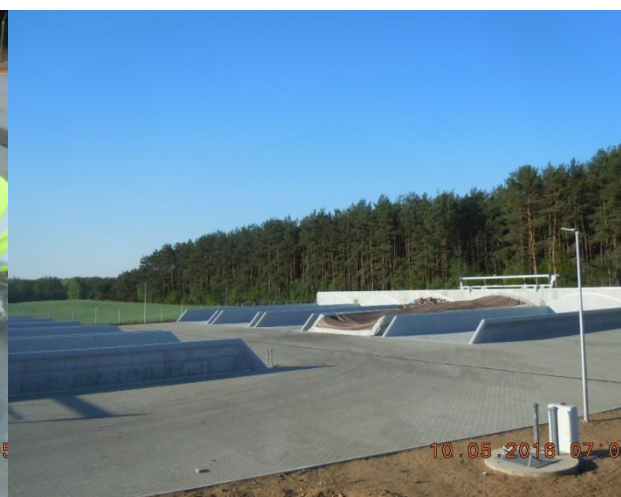
Rysunek 32 Tak jest. Nowa instalacja do biologicznego przetwarzania odpadów z możliwością kompostowania odpadów zielonych, Puszcza Miejska (foto: Puszcza Miejska, marzec 2016r).
