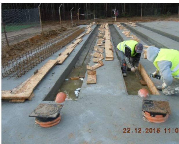
Rysunek 31 Tak było. Instalacja do biologicznego przetwarzania odpadów, w trakcie budowy, Puszcza Miejska (foto: Puszcza Miejska, grudzień 2015r).
