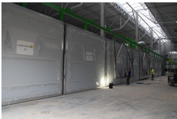
Rysunek 15 Tak było. Instalacja do stabilizacji i kompostowania -w budowie, Zakurzewo (sierpień 2013r)
