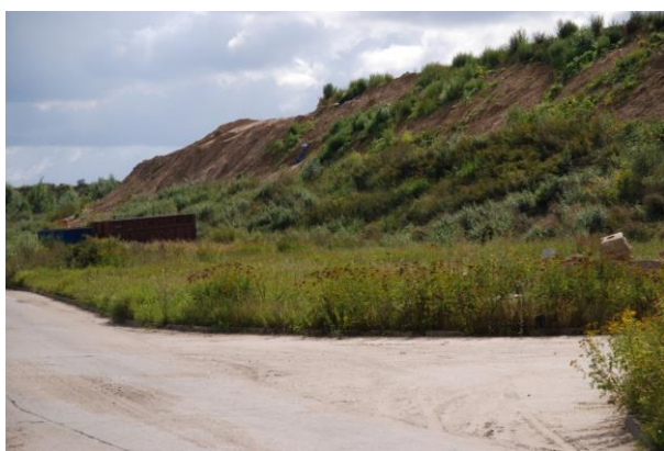
Rysunek 59 Instalacja stabilizacji frakcji biodegradowalnej wydzielonej ze zmieszanych odpadów komunalnych - kopiec BIO-EN-ER, Bydgoszcz ProNatura (sierpień 2013r)
