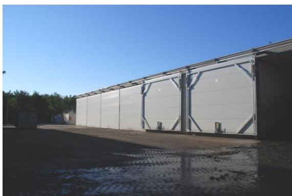
Rysunek 51 Tak było. Instalacja stabilizacji frakcji biodegradowalnej wydzielonej ze zmieszanych odpadów komunalnych- bioreaktory, Remondis Bydgoszcz (sierpień 2013r)
