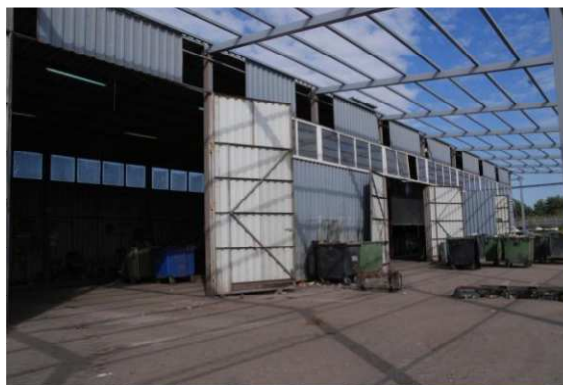
Rysunek 34 Tak było. Sortownia odpadów komunalnych, Lipno – rozbudowa budynku (sierpień 2013r)
