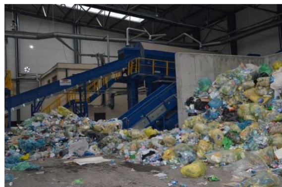
Rysunek 8 Tak jest. Nowa sortownia odpadów (komunalnych zmieszanych i surowcowych), Sulnówko (foto: Sulnówko, wrzesień 2015r).
