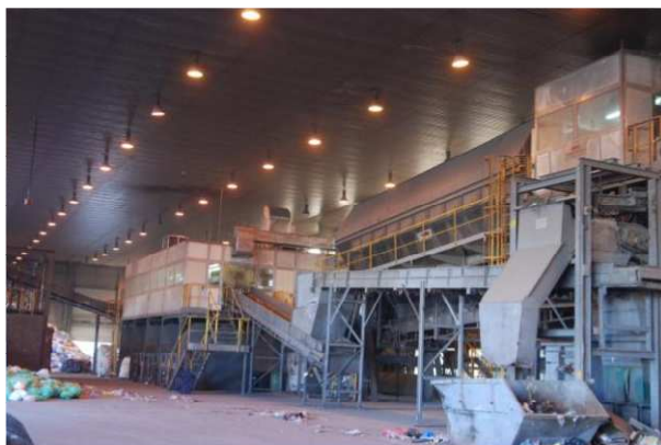
Rysunek 49 Tak było i jest. Sortownia odpadów komunalnych, Remondis Bydgoszcz (sierpień 2013r)
