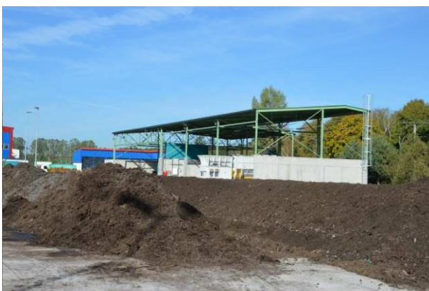
Rysunek 61 Tak jest. Kompostownia odpadów zielonych, Bydgoszcz ProNatura (foto: Bydgoszcz, październik 2015r)
