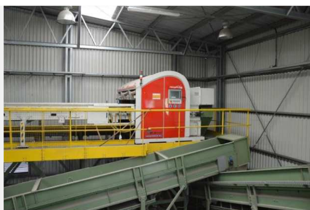
Rysunek 24 Tak było i jest. Separator optoelektroniczny w sortowni odpadów komunalnych, Niedźwiedź (foto: Niedźwiedź, wrzesień 2015r.)
