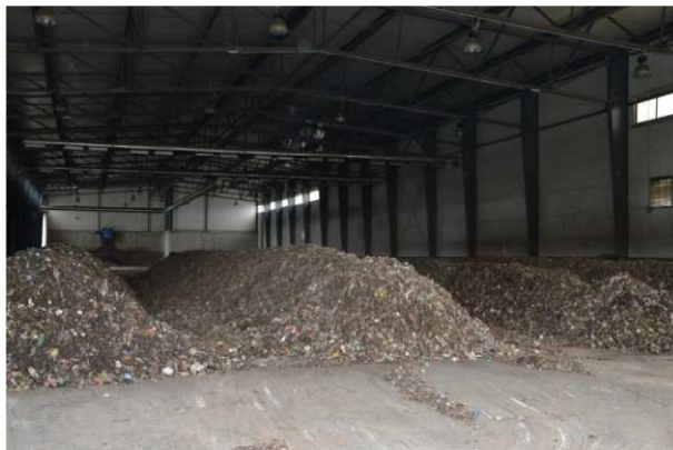
Rysunek 9 Tak jest. Nowa instalacja do biologicznego przetwarzania odpadów z możliwością kompostowania odpadów zielonych, Sulnówko (foto: Sulnówko, wrzesień 2015r).
