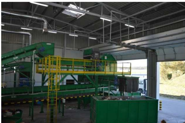
Rysunek 3 Tak jest. Nowa sortownia odpadów komunalnych (zmieszanych i surowcowych), Bładowo (foto: Bładowo, październik 2015r).
