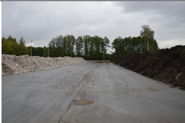
Rysunek 11 Tak jest. Nowa kompostownia polowa odpadów zielonych oraz plac dojrzwiania stabilizatu, Sulnówko (foto: Sulnówko, wrzesień 2015r).
