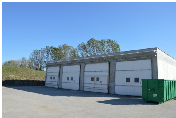
Rysunek 4 Tak jest. Nowa instalacja do biologicznego przetwarzania odpadów z możliwością kompostowania odpadów zielonych, Bładowo (foto: Bładowo, październik 2015r).
