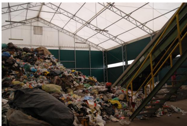
Rysunek 66 Sortownia odpadów komunalnych, Służewo (sierpień 2013r)
