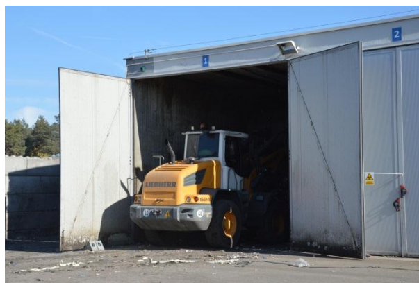
Rysunek 44 Tak jest. Instalacja stabilizacji frakcji biodegradowalnej wydzielonej ze zmieszanych odpadów komunalnych wraz z funkcją kompostowania odpadów zielonych- faza eksploatacji, CORIMP Bydgoszcz (foto: CORIMP Bydgoszcz, październik 2015r)
