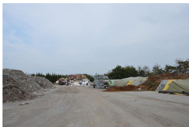
Rysunek 69 Instalacja stabilizacji frakcji biodegradowalnej wydzielonej ze zmieszanych odpadów komunalnych wraz z funkcją kompostowania odpadów zielonych- Służewo (foto: Służewo, wrzesień 2015r)
