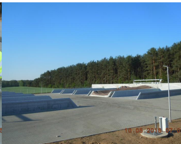
Rysunek 32 Tak jest. Nowa instalacja do biologicznego przetwarzania odpadów z możliwością kompostowania odpadów zielonych, Puszcza Miejska (foto: Puszcza Miejska, marzec 2016r).
