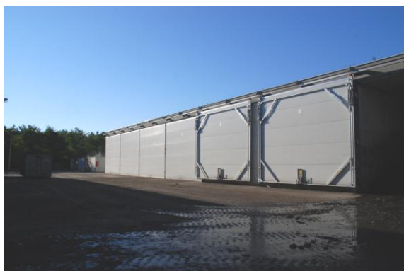
Rysunek 51 Tak było. Instalacja stabilizacji frakcji biodegradowalnej wydzielonej ze zmieszanych odpadów komunalnych- bioreaktory, Remondis Bydgoszcz (sierpień 2013r)
