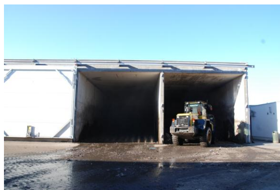
Rysunek 52 Tak Było. Instalacja stabilizacji frakcji biodegradowalnej wydzielonej ze zmieszanych odpadów komunalnych- napełnianie rektorów, Remondis Bydgoszcz (sierpień 2013r)
