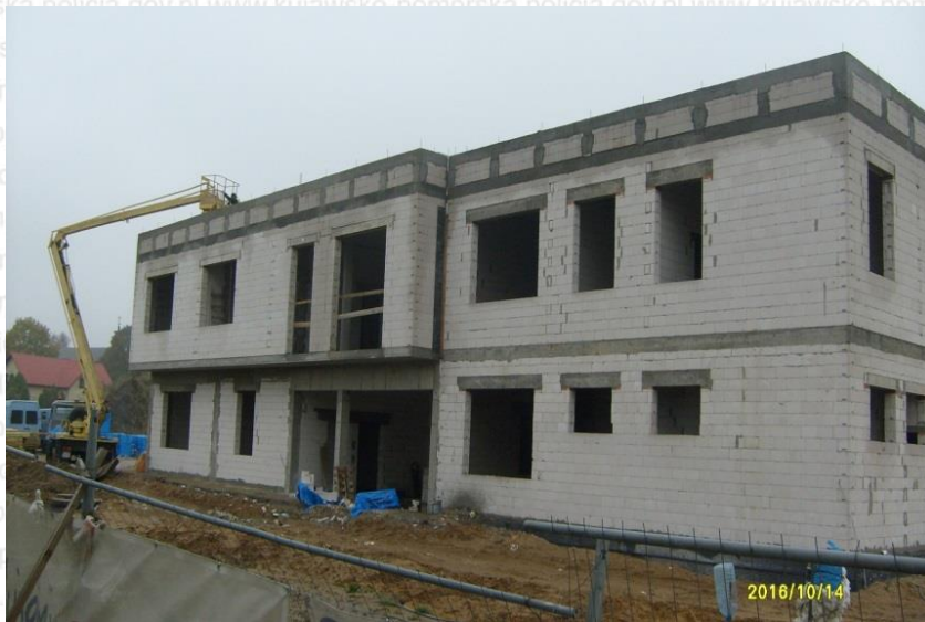
W trakcie realizacji
