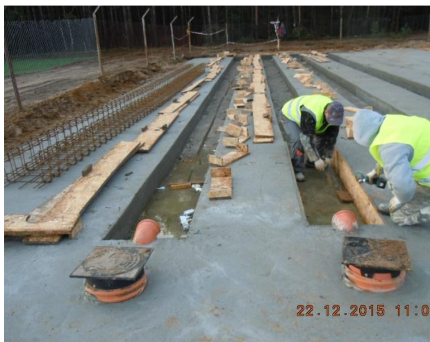
Rysunek 31 Tak było. Instalacja do biologicznego przetwarzania odpadów, w trakcie budowy, Puszczka Miejska (foto: Puszczka Miejska, grudzień 2015r).
