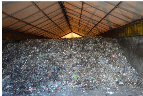
Rysunek 73 Tak jest. Instalacja stabilizacji frakcji biodegradowalnej wydzielonej ze zmieszanych odpadów komunalnych, Toruń MPO (Toruń, MPO, wrzesień 2015r)
