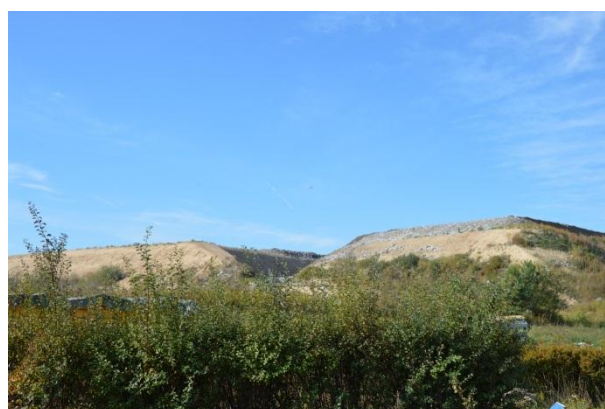
Rysunek 60 Tak jest. Kopiec BIO-EN-ER, do rozbiórki po okresie rozkładu masy organicznej, Bydgoszcz ProNatura (foto: Bydgoszcz, październik 2015r)
