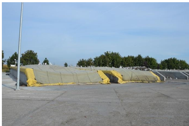
Rysunek 21 Tak jest. Nowa instalacja do biologicznego przetwarzania odpadów z możliwością kompostowania odpadów zielonych, Osnowo (foto: Osnowo, wrzesień 2015r).
