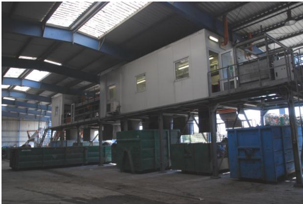
Rysunek 82 Tak było. Sortownia odpadów komunalnych, Inowrocław (sierpień 2013r)
