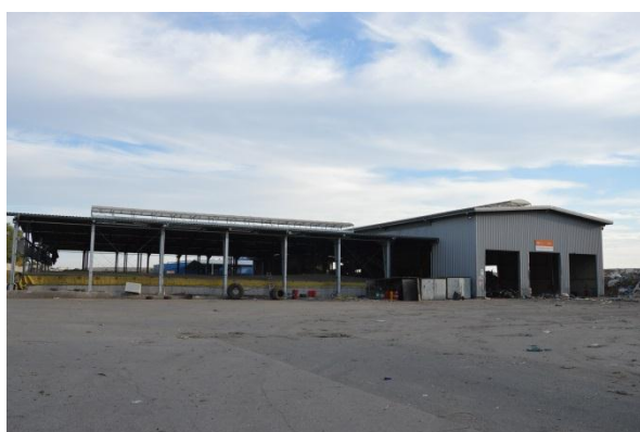
Rysunek 76 Tak było i jest. Sortownia i instalacja biologicznego przetwarzania odpadów komunalnych, Wawrzynki (foto: Wawrzynki, październik 2015r)
