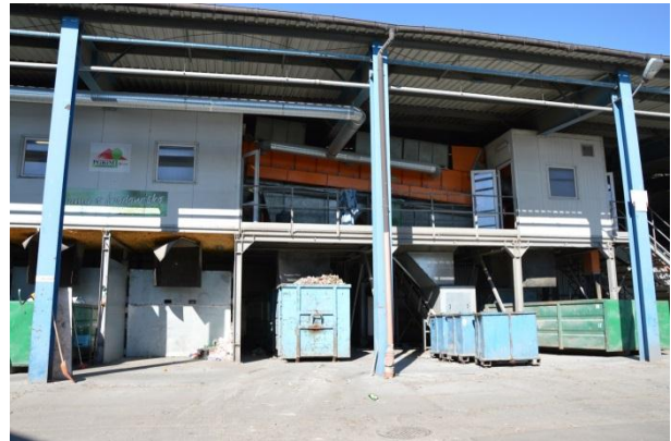
Rysunek 83 Tak jest. Sortownia odpadów komunalnych zmieszanych i częściowo selektywnie zebranych, Inowrocław (fot: Inowrocław. Wrzesień 2015r)
