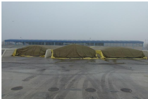
Rysunek 40 Tak jest. Nowa instalacja do biologicznego przetwarzania odpadów z możliwością kompostowania odpadów zielonych, Machnacz (foto: Machnacz, wrzesień 2015r.).
