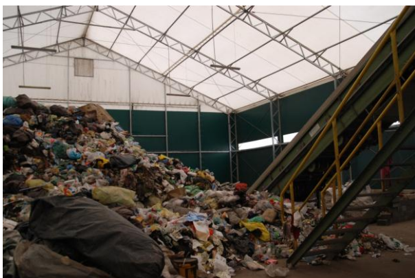
Rysunek 66 Sortownia odpadów komunalnych, Służewo (sierpień 2013r)
