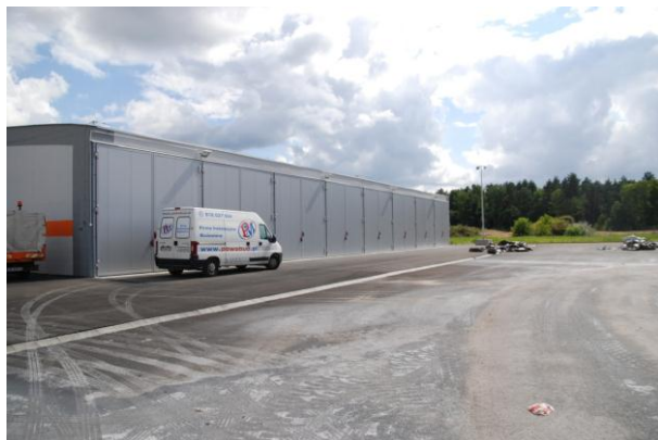
Rysunek 43 Tak było. Instalacja stabilizacji frakcji biodegradowalnej wydzielonej ze zmieszanych odpadów komunalnych - faza rozruchu, CORIMP Bydgoszcz (sierpień 2013r.)
