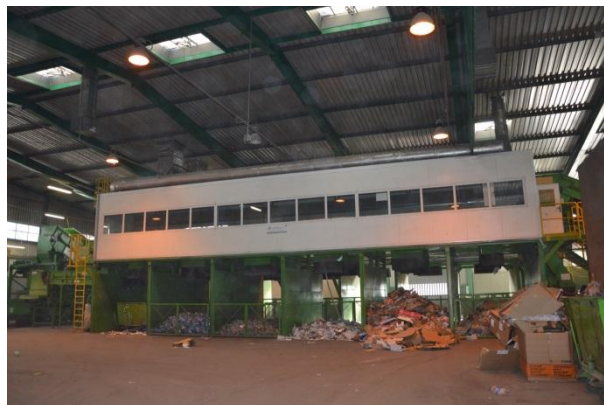
Rysunek 71 Tak jest. Sortownia odpadów komunalnych mieszanych i selektywnie zebranych, Toruń MPO (foto: Toruń, MPO, wrzesień 2015r)
