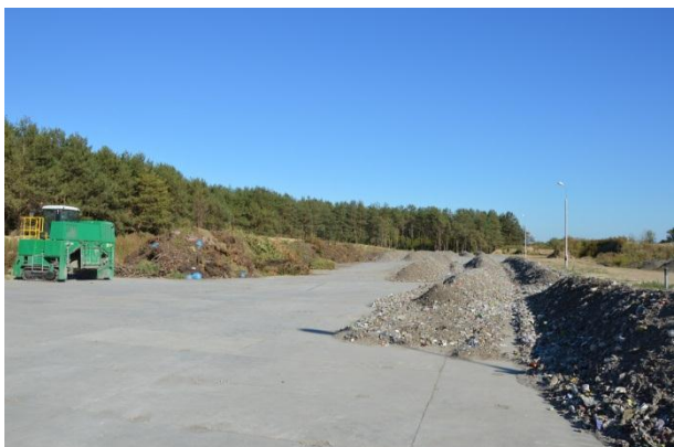
Rysunek 5 Tak jest. Nowa polowa kompostowania odpadów zielonych wraz z placem dojrzewania stabilizatu, Bładowo (foto: Bładowo, październik 2015r).
