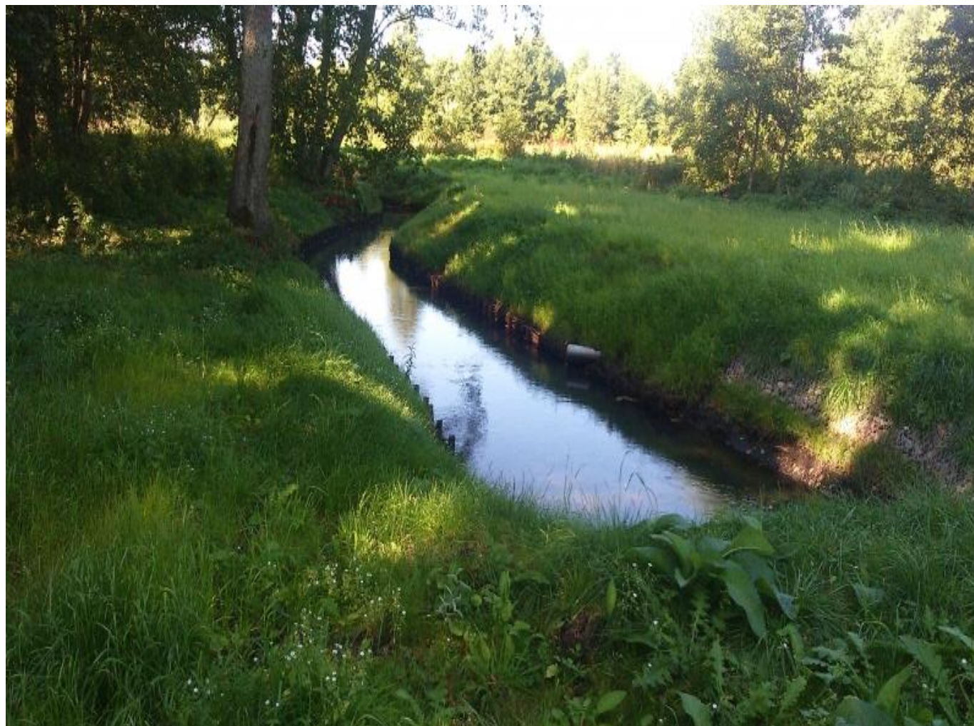
Fot. Kanał Jeleń – inwestycja zrealizowana w 2014 r.
