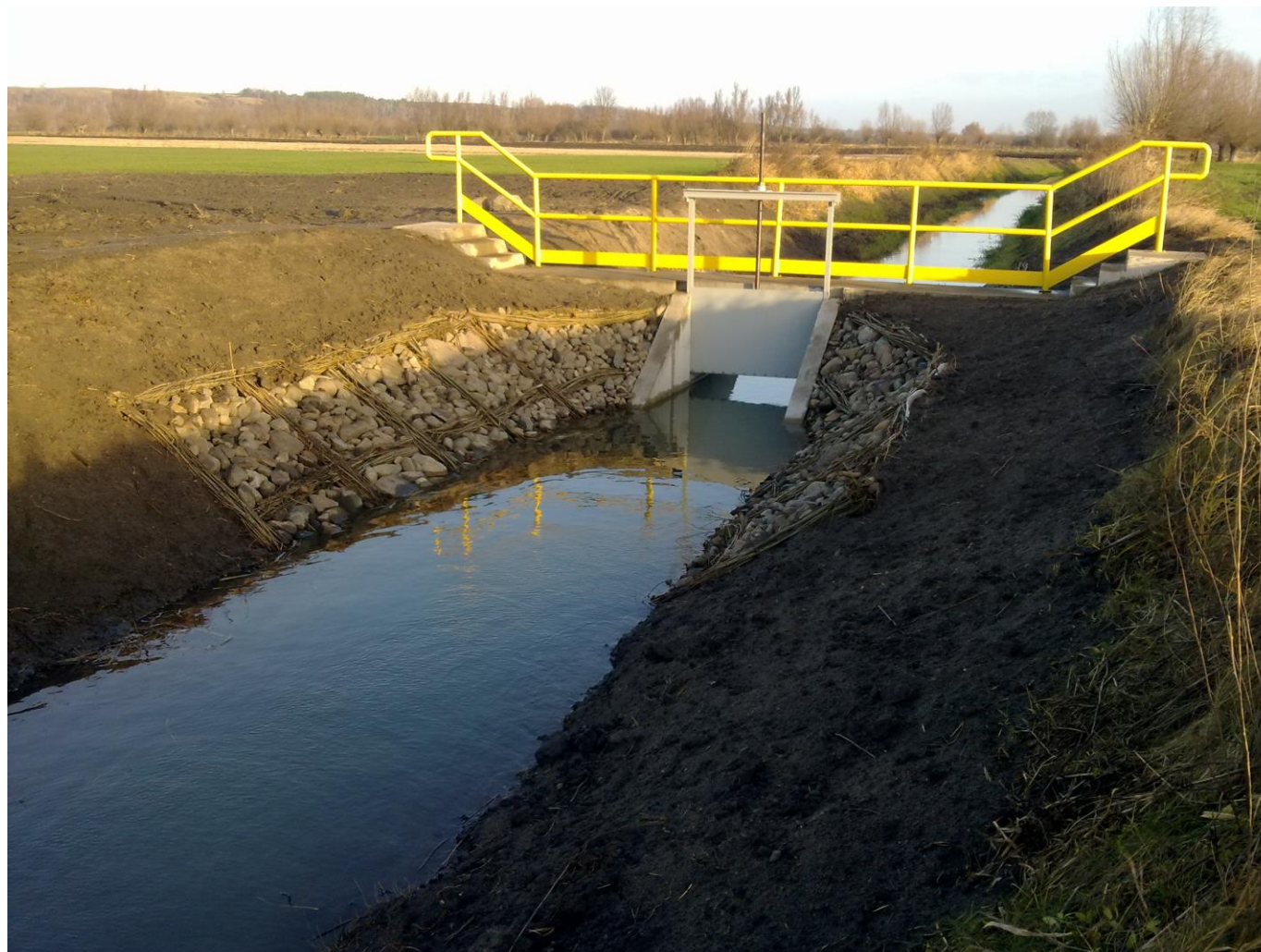
Fot. Kanał Główny Świecki – inwestycja zrealizowana w 2011 r.
