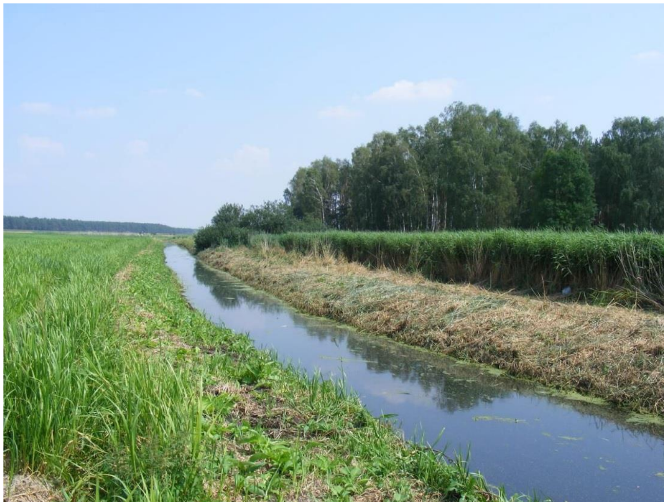
Fot. Kanał Bachorza Duża km 7+270
