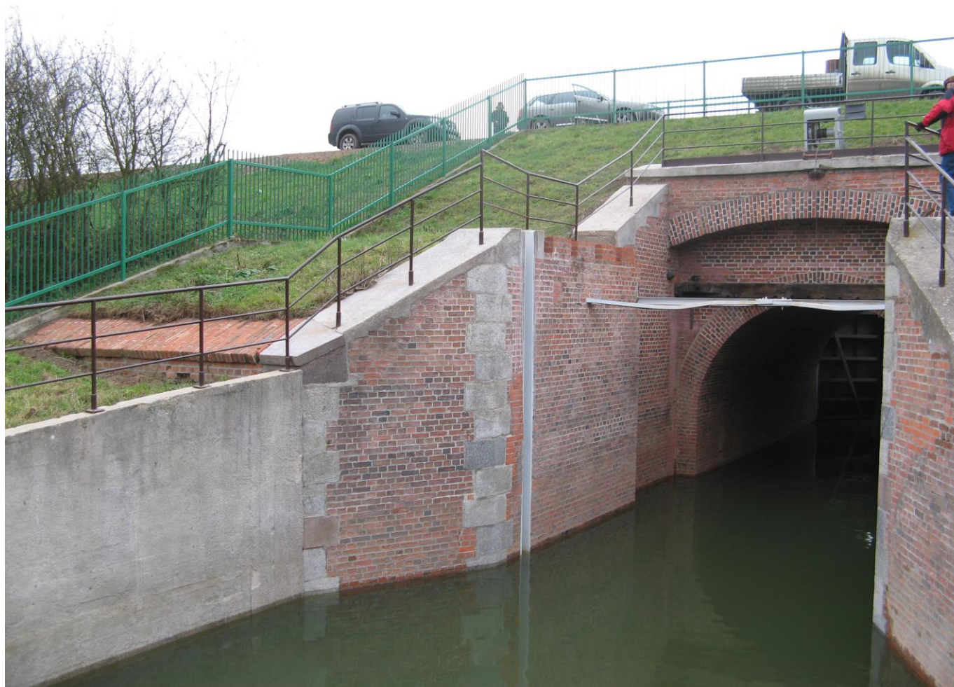
Fot. Wał Miejskiej Niziny Chełmińskiej – inwestycja zrealizowana w 2012 r.
