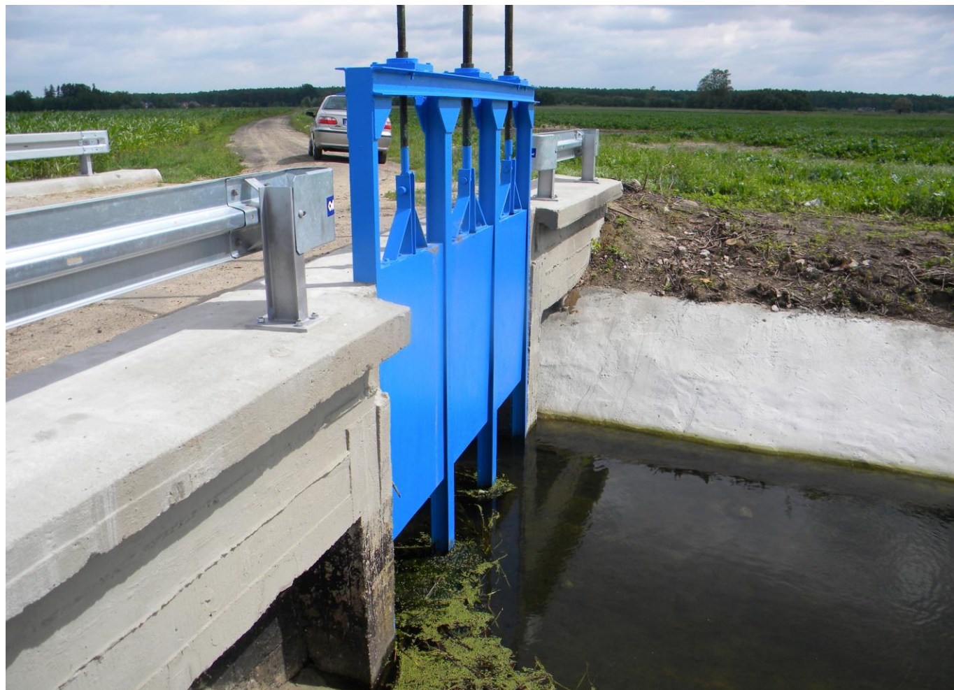
Fot. Kanał Dolnej Niziny Toruńskiej – inwestycja zrealizowana w 2013 r.
