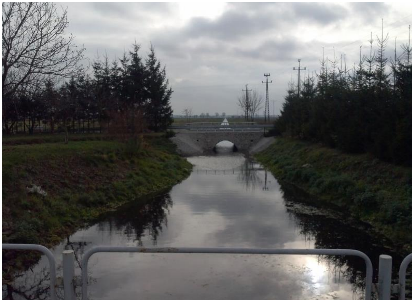
Fot. Kanał Parczański – inwestycja zrealizowana w 2013 r.
