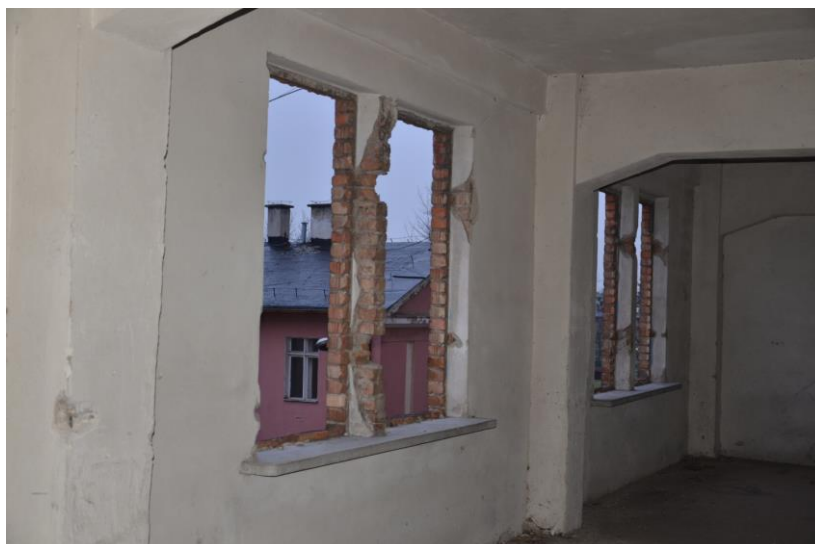
fot. 1.14. Uszkodzenia filarków międzyokiennych.
