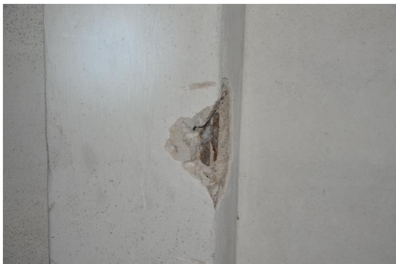
fot. 2.13. Odkrywka zbrojenia nr 5.4, słup 5-piętra zewnętrzny.
