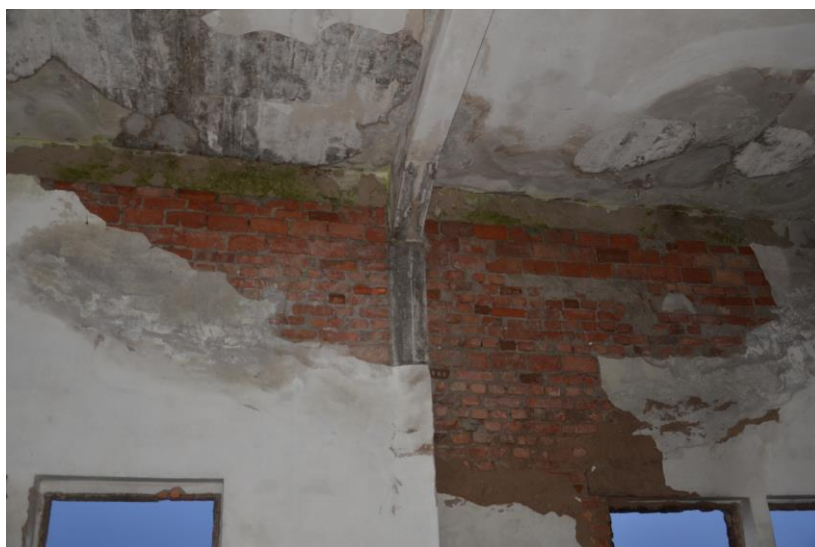
fot. 1.15. Zawilgocenie ścian zewnętrznych 5 piętra i stropodachu.
