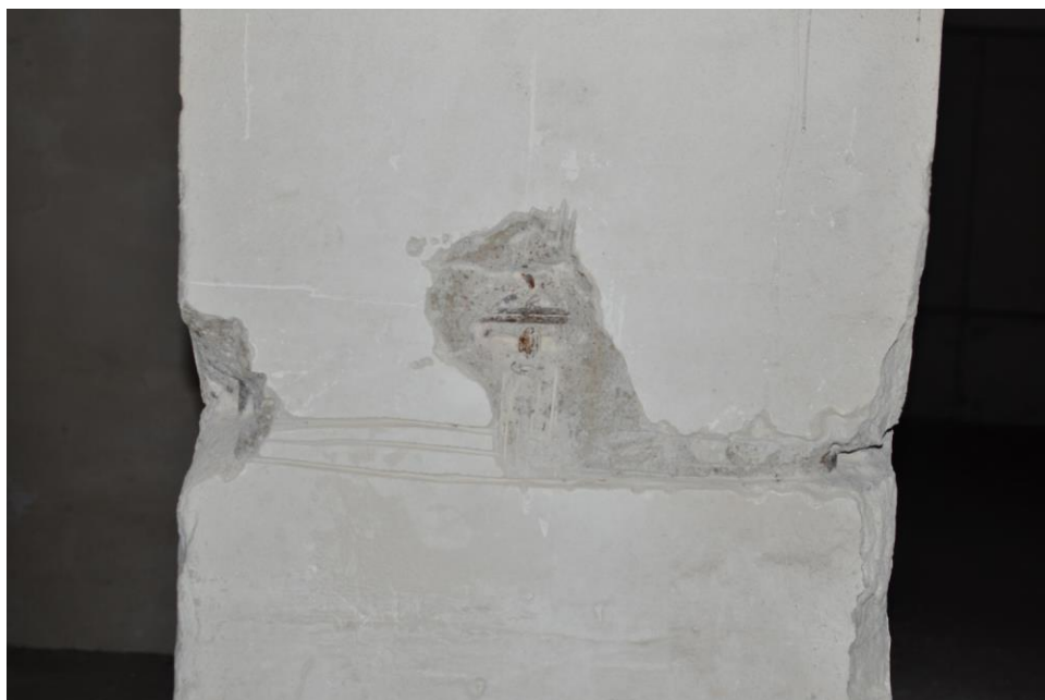
fot. 2.2. Odkrywka zbrojenia nr 1.1, słup 1-piętra wewnętrzny.
