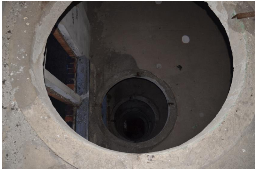
fot. 1.11. Otwory zsypowe w stropach.
