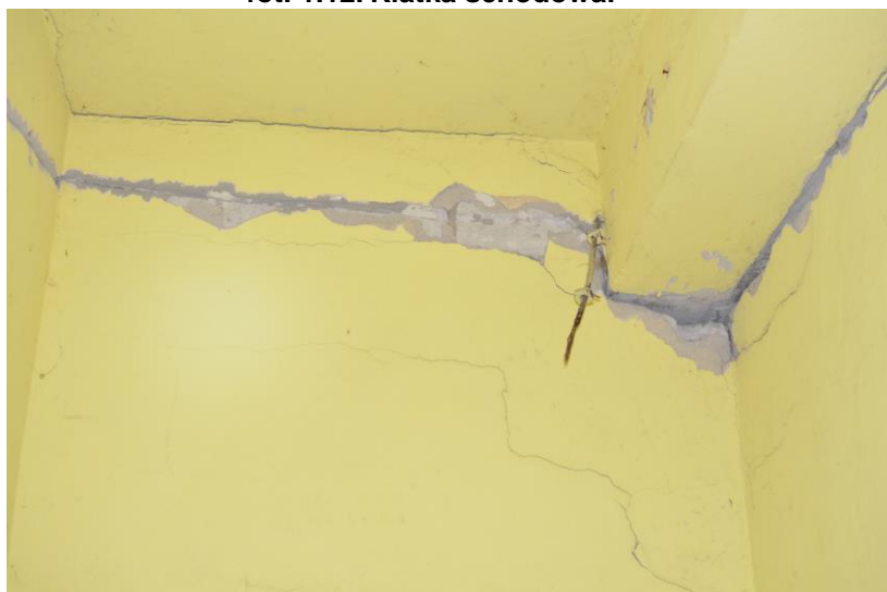
fot. 1.13. Pęknięcia ścian wewnętrznych
