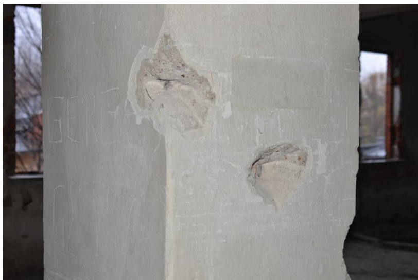
fot. 2.3. Odkrywka zbrojenia nr 1.2, słup 1-piętra wewnętrzny.
