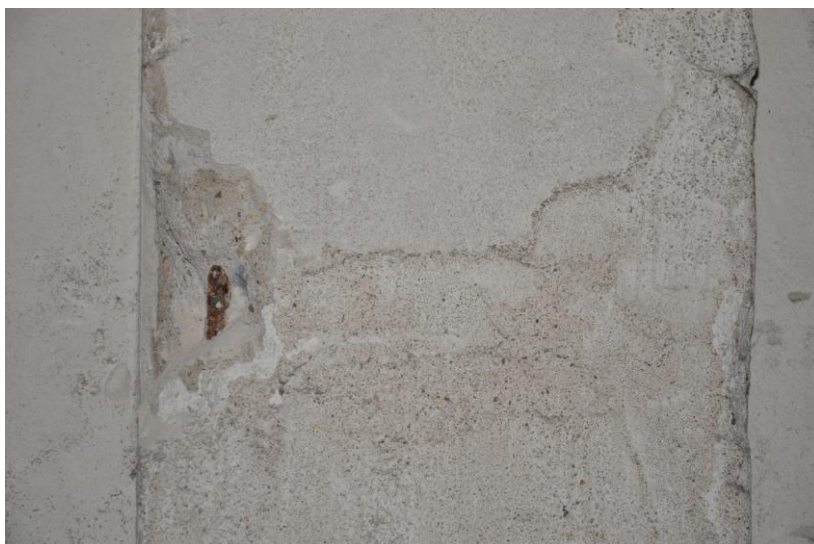
fot. 2.8. Odkrywka zbrojenia nr 3.2, słup 3-piętra zewnętrzny.
