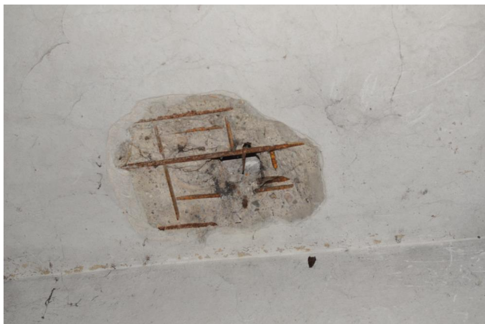
fot. 4.2.Odkrywka zbrojenia stropu nr 1.6.
