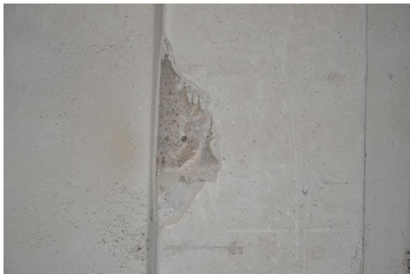
fot. 2.10. Odkrywka zbrojenia nr 4.3, słup 4-piętra zewnętrzny.
