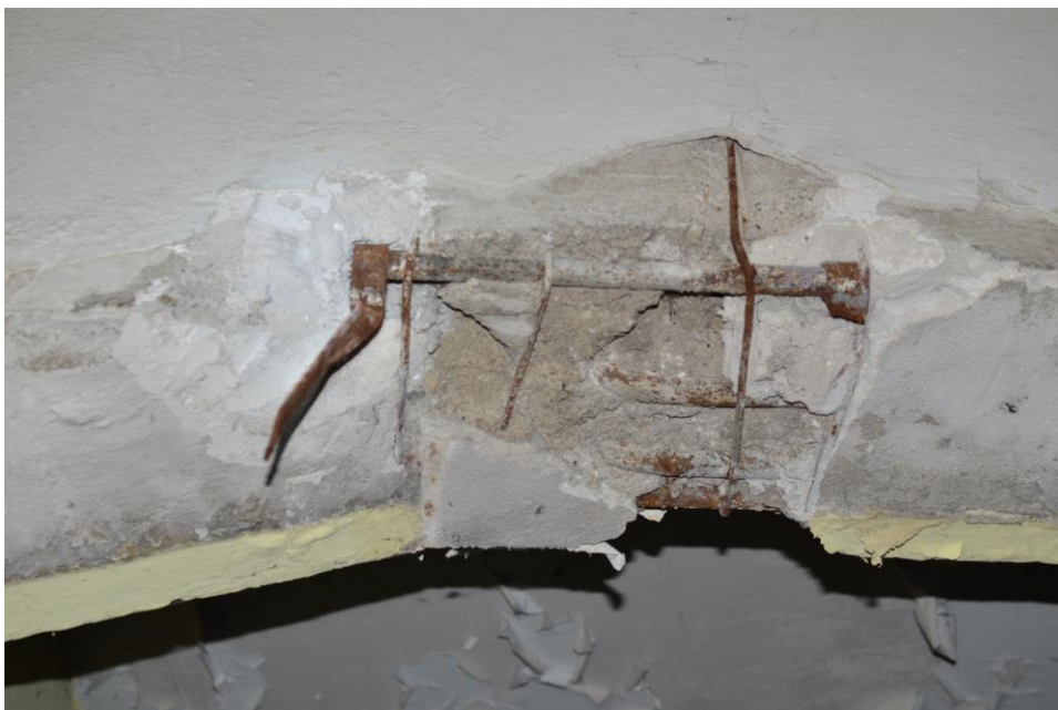
fot. 3.1. Odkrywka nr 1.5 - zbrojenia belki nad parterem.
