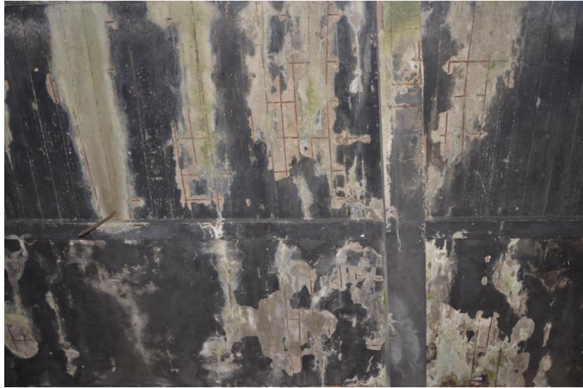
fot. 1.17. Stan zbrojenia zadaszenia rampy od strony zachodniej.
