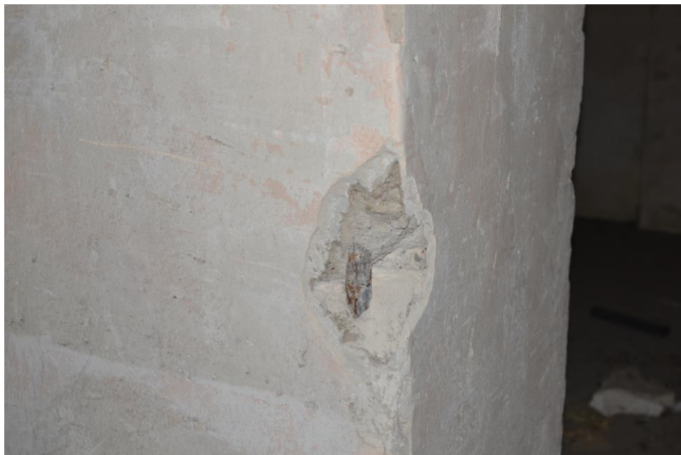
fot. 2.1. Odkrywka zbrojenia nr 0.1, słup parteru wewnętrzny.
