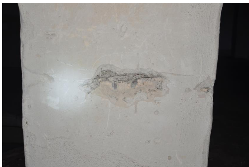
fot. 2.5. Odkrywka zbrojenia nr 2.1, słup 2-piętra wewnętrzny.
