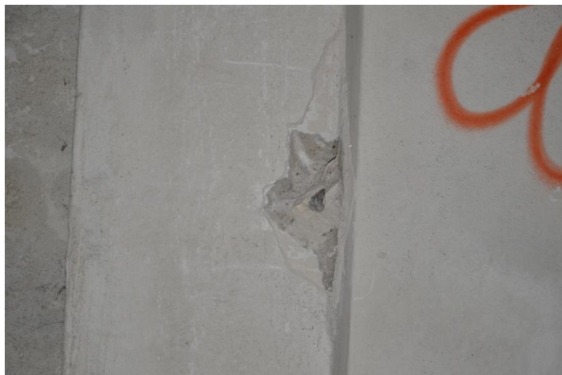
fot. 2.9. Odkrywka zbrojenia nr 4.2, słup 4-piętra zewnętrzny.
