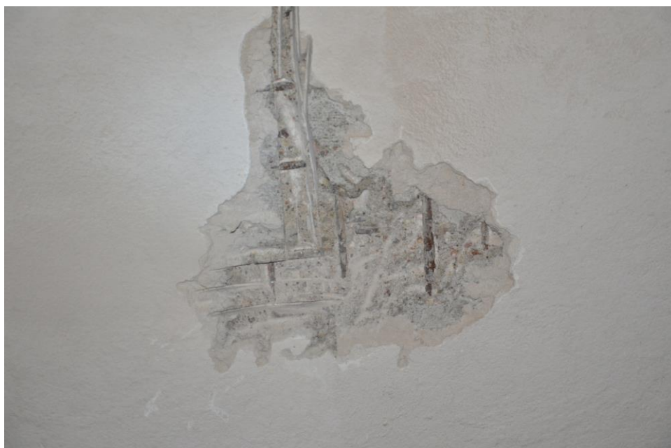
fot. 4.3. Odkrywka zbrojenia stropu nr 2.6.
