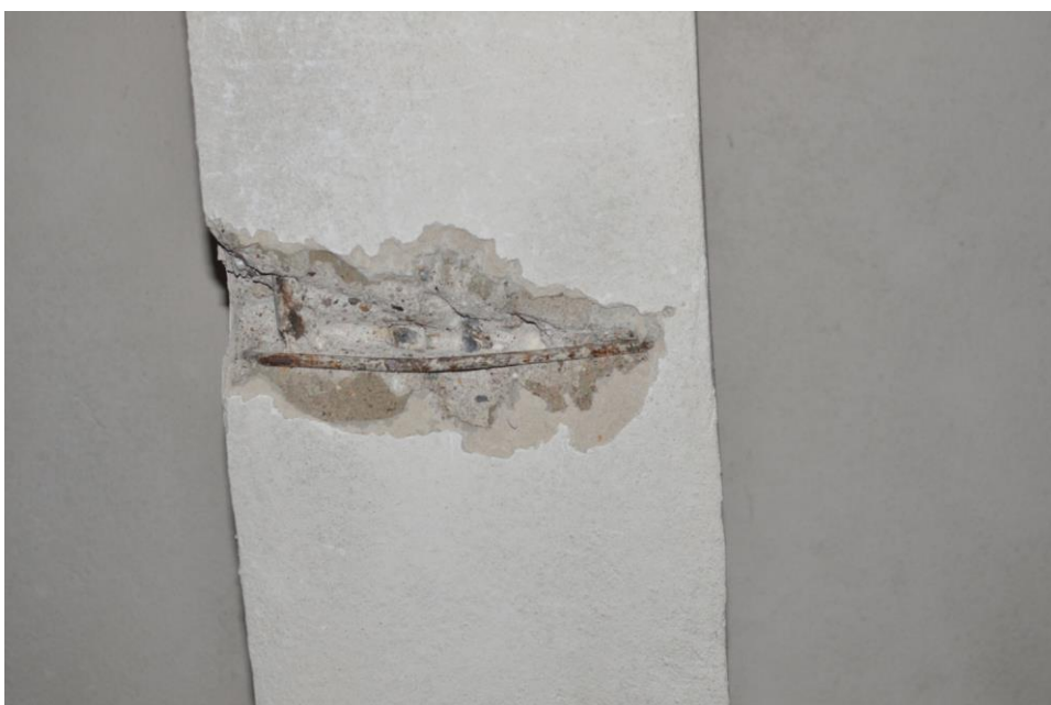
fot. 3.2. Odkrywka nr 2.3 - zbrojenia belki nad 1 piętro.
