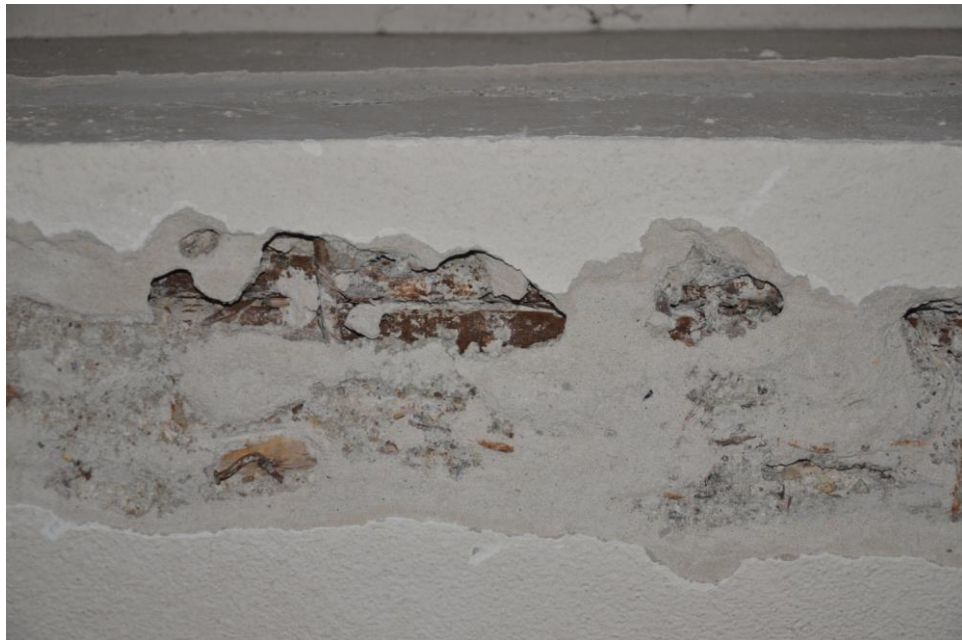
fot. 3.3. Odkrywka nr 2.4 - zbrojenia belki nad 1 piętrem.
