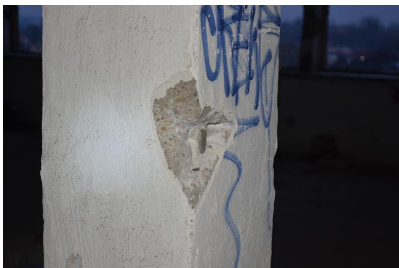
fot. 2.11. Odkrywka zbrojenia nr 5.1, słup 5-piętra wewnętrzny.
