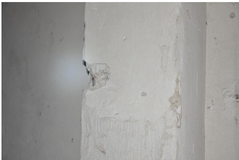
fot. 2.6. Odkrywka zbrojenia nr 2.2, słup 2-piętra zewnętrzny.
