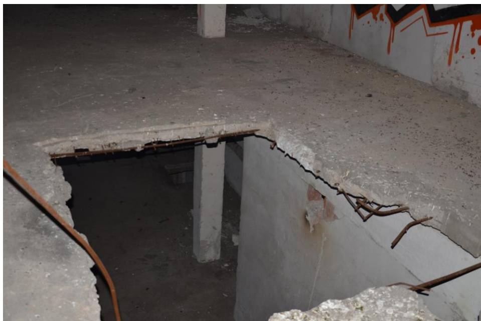
fot. 4.4. Odkrywka zbrojenia stropu nr 5.6
