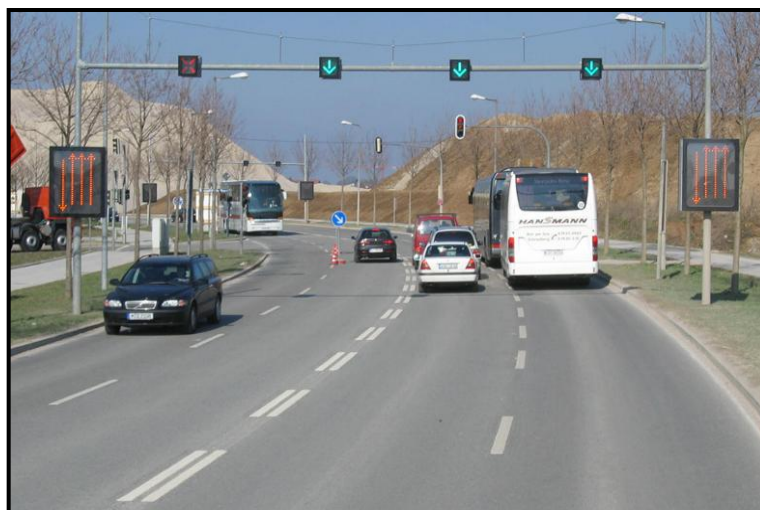
Fot. 3. Przykład sterowania ruchem na drodze jednojezdniowej, czteropasowej w pobliżu terenów targowych, gdzie następują znaczne problemy z płynnością ruchu w określonych kierunkach i porach dnia (Niemcy – Monachium)
