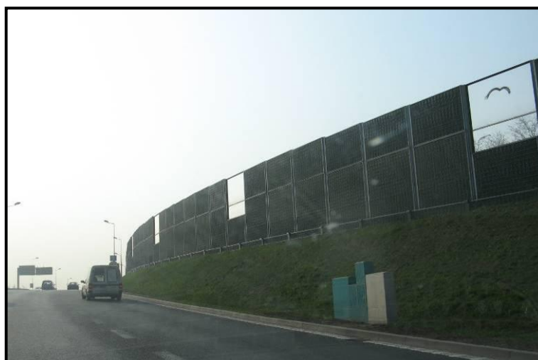
Fot. 10. Przykład kombinacji ekranu ziemnego z ekranem akustycznym (droga krajowa nr 4 na odcinku Kraków - Tarnów)
