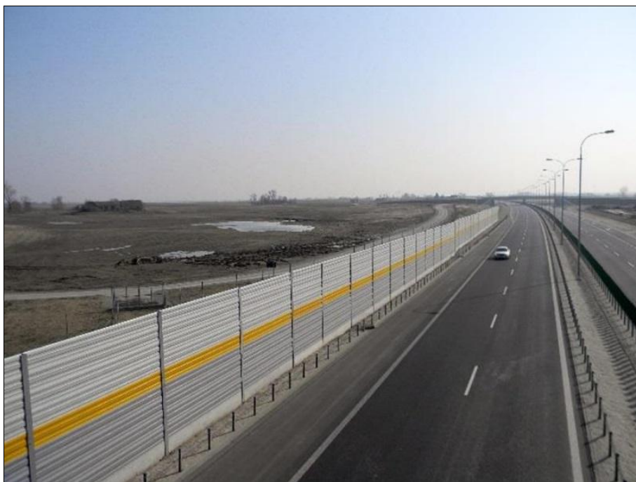
Zdj. Przykład realizacji ekranów akustycznych (Autostrada A1 112+550)
