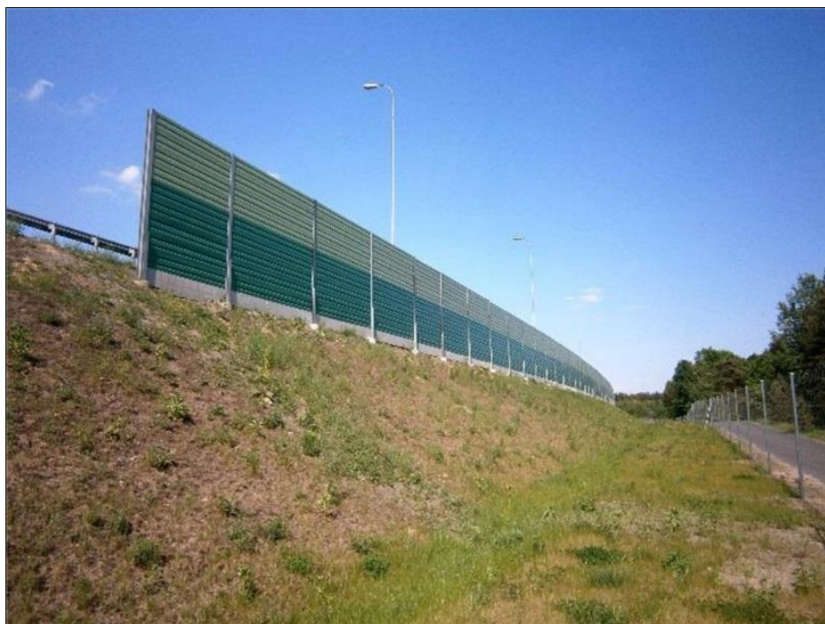
Zdj. Przykład realizacji ekranów akustycznych (Autostrada A1 148+850)
