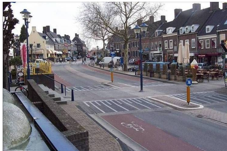
Fot. 6. Przykład strefy ruchu uspokojenego o dopuszczalnej prędkości 30 km/h w centrum miejscowości (Holandia)
