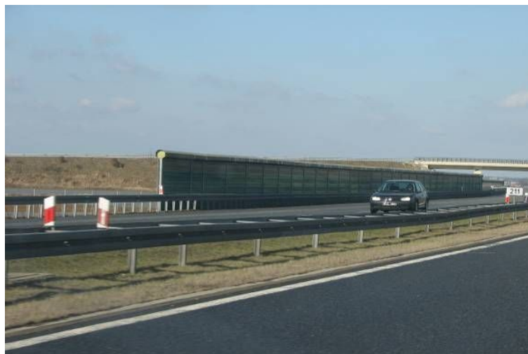
Fot. 8. Przykład typowego zastosowania ekranu akustycznego na autostradzie A4 (Polska)
