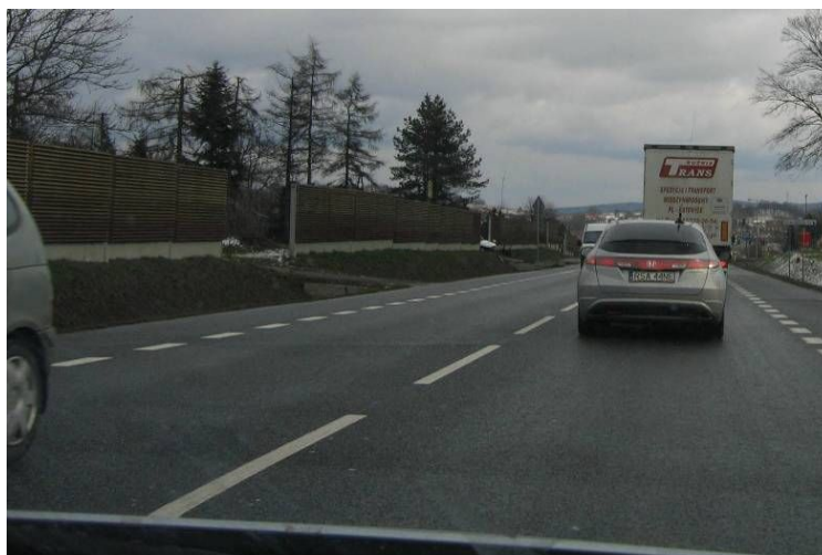
Fot. 2. Konieczność zapewnienia zjazdu do posesji – przerwanie ciągłości ekranu akustycznego i słaba jego skuteczność (droga krajowa nr 4 na odcinku Kraków - Tarnów)
