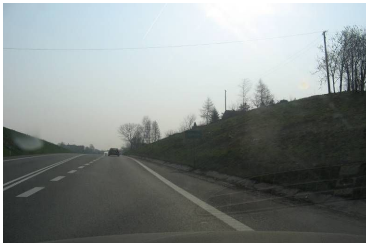
Fot. 1. Wykorzystanie ekranujących własności wykopu (droga krajowa nr 4 na odcinku Kraków - Tarnów)
