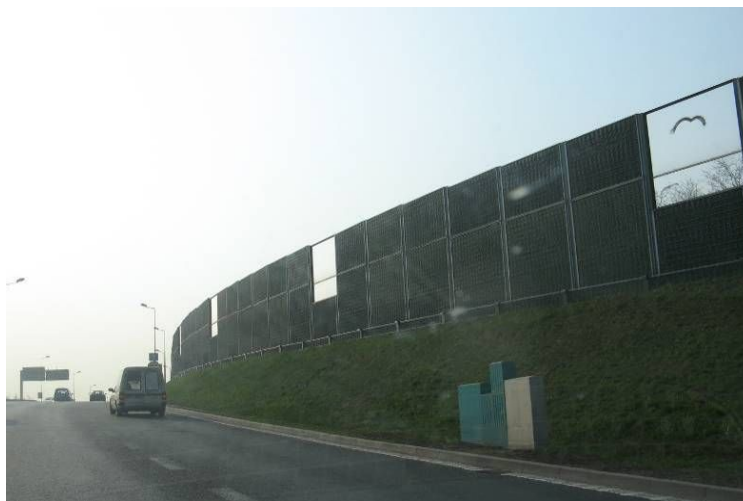
Fot. 10. Przykład kombinacji ekranu ziemnego z ekranem akustycznym (droga krajowa nr 4 na odcinku Kraków - Tarnów)
