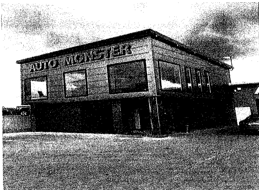
Fot Nr 5 Widok budynku stacji demontażu od frontu
