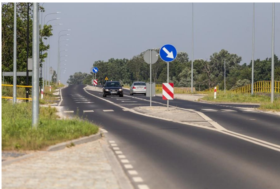
Zmodernizowana droga wojewódzka 265, fot. Szymon Zdziebło
