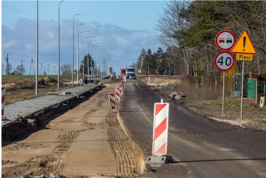
Prace na DW 548 na odcinku Stolno-Wąbrzeźno, fot. Szymon Zdziebło
