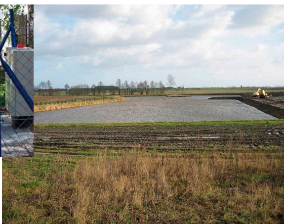
Fot. 27. Budowa i renowacja zbiorników retencyjnych w powiecie tucholskim w miejscowości Bysław
