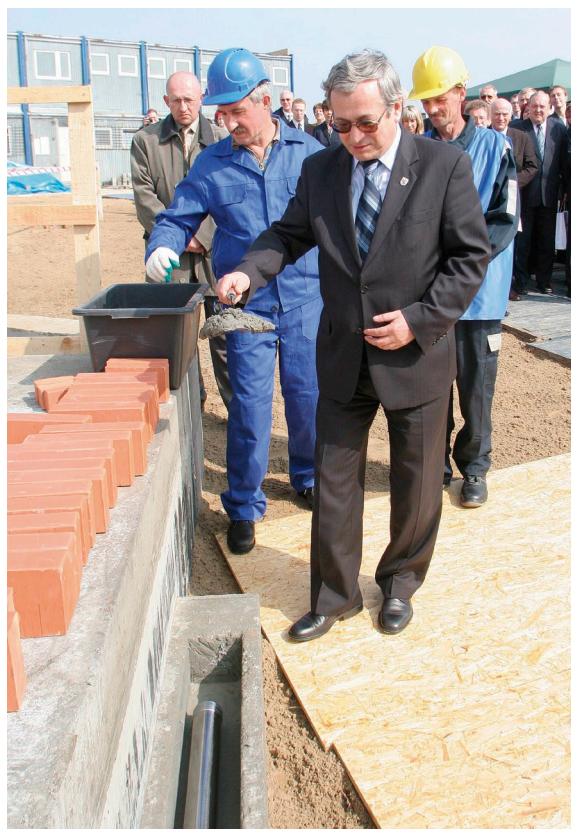
Fot. 45. Wmurowanie kamienia węglanego pod budowę Regionalnego Centrum Innowacji przy ATR w Bydgoszczy
