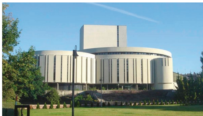
Fot. 16. Kontynuacja budowy Opery Nova w Bydgoszczy
