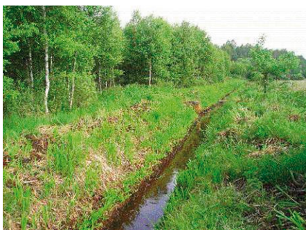
Fot. 28. Rów melioracyjny
