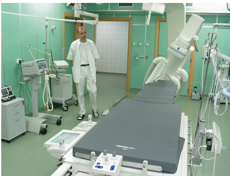
Fot. 5. Wyposażenie pracowni kardiologii inwazyjnej w Szpitalu Wojewódzkim we Włocławku
