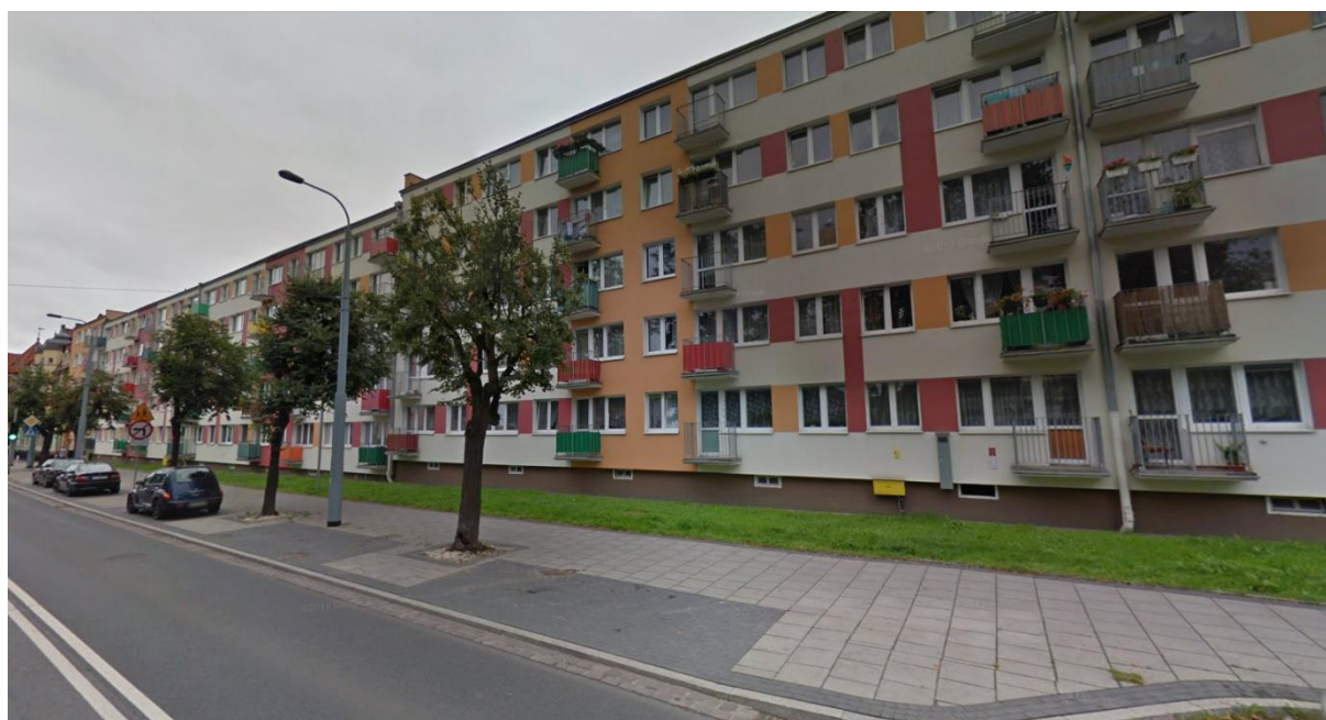
Przykładowa zabudowa mieszkaniowo-usługowa - ulica Legionów
