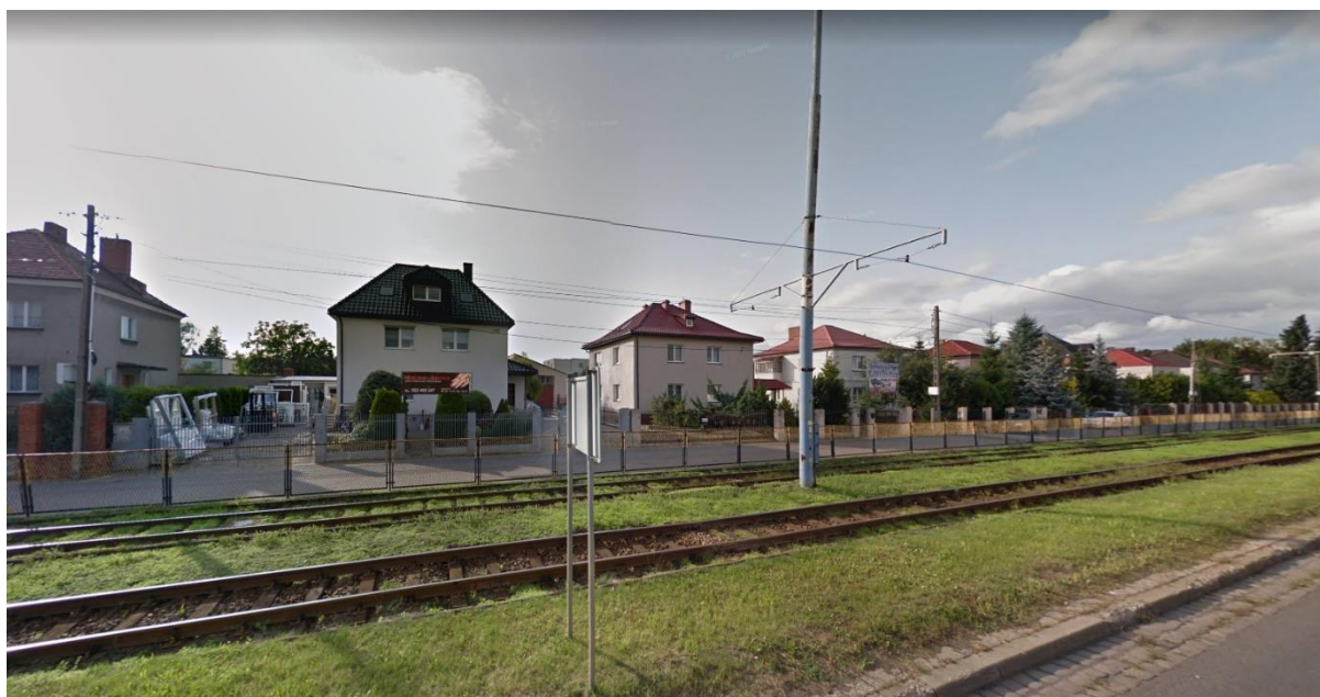
Przykładowa zabudowa mieszkaniowa jednorodzinna – droga nr 498, ulica Chełmińska
