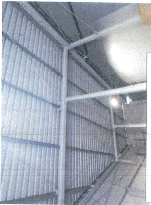
Zdjęcie nr 7- naświetla w dachu bud. produkcyjnego
