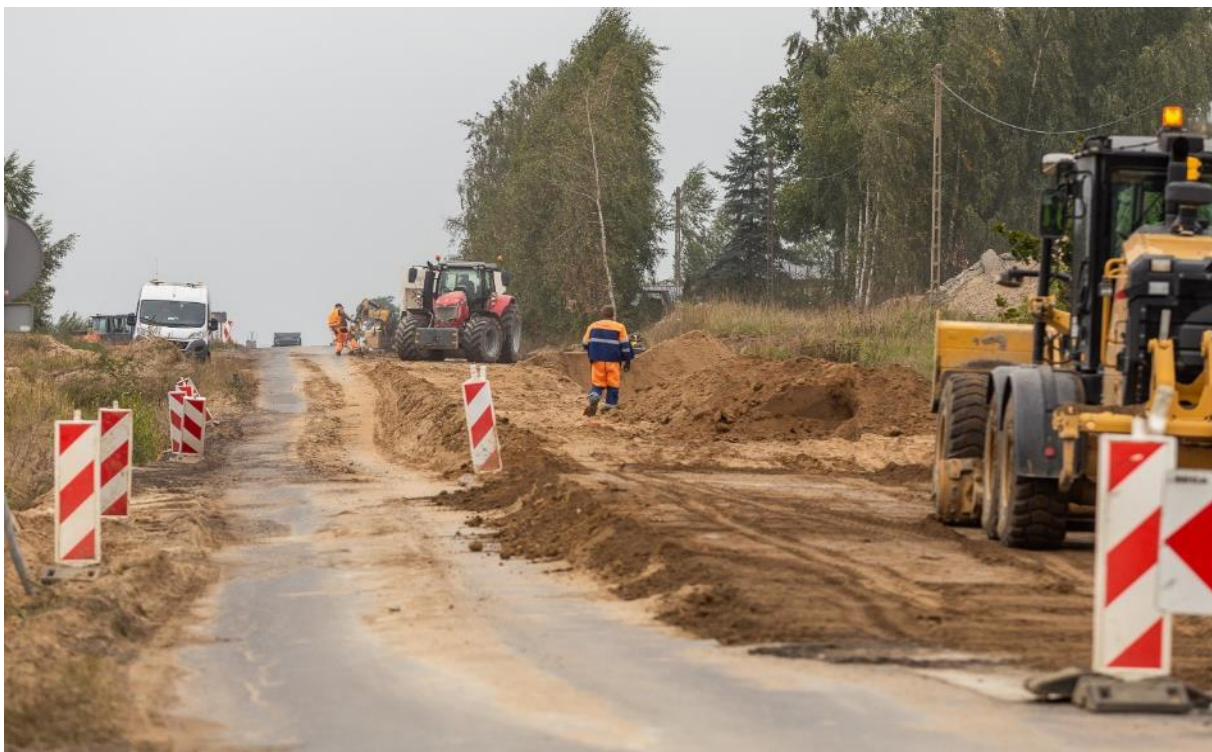
Prace na DW 548 na odcinku Lisewo – Stolno, fot. Szymon Zdziebło
