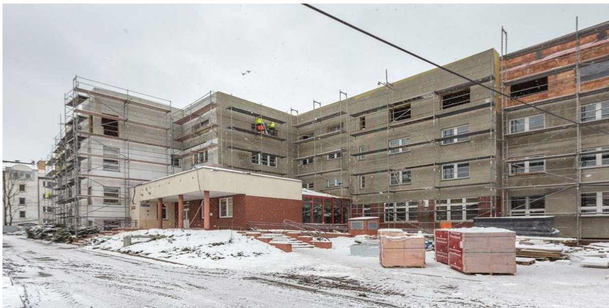
Budowa i remont Specjalnego Ośrodka Szkolno-Wychowawczego im. J. Korczaka w Toruniu, fot. Szymon Zdziebło
