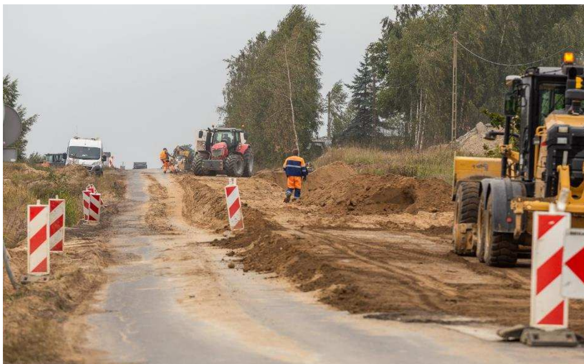
Prace na DW 548 na odcinku Lisewo – Stolno, fot. Szymon Zdziebło
