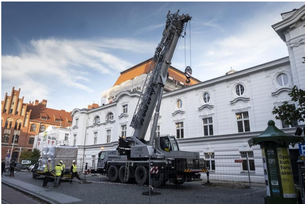
Prace modernizacyjne budynku Teatru im. Wilama Horzycy w Toruniu, fot. Wojciech Szabelski
