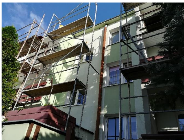
brak lub niewłaściwe urządzenia ochronne na rusztowaniach
