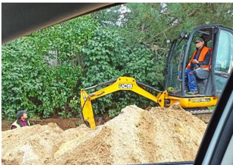
brak umocnienia, rozparcia lub podparcia ścian wykopu wąskoprzestrzennego o głębokości ponad 1,0 m oraz składowania urobku w odległości nie mniejszej niż 0,6 m od krawędzi wykopu
