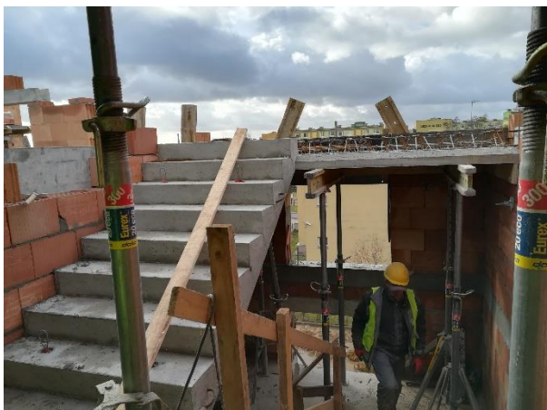
brak zabezpieczenia przed upadkiem z wysokości; brak bezpiecznego dojścia do stanowisk; brak zabezpieczenia otworu na szyb dźwigowy
