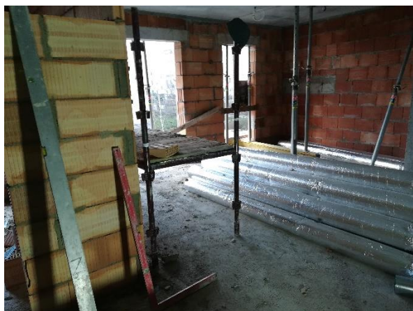
brak lub niewłaściwe urządzenia ochronne na rusztowaniach
