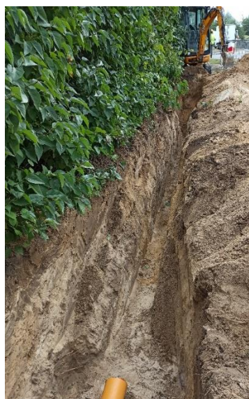
brak umocnienia, rozparcia lub podparcia ścian wykopu wąskoprzestrzennego o głębokości ponad 1,0 m oraz składowania urobku w odległości nie mniejszej niż 0,6 m od krawędzi wykopu
