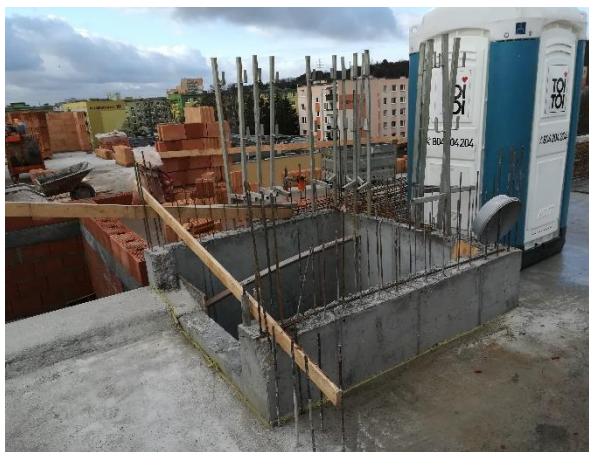
brak zabezpieczenia przed upadkiem z wysokości; brak bezpiecznego dojścia do stanowisk; brak zabezpieczenia otworu na szyb dźwigowy
