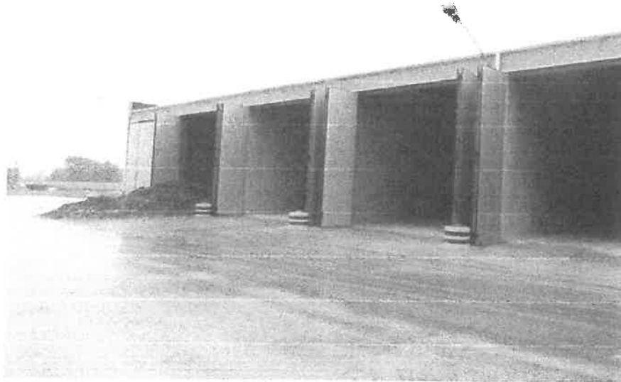
Fot. nr 2 – Budynek Bioreaktorów z wentylatorownią
