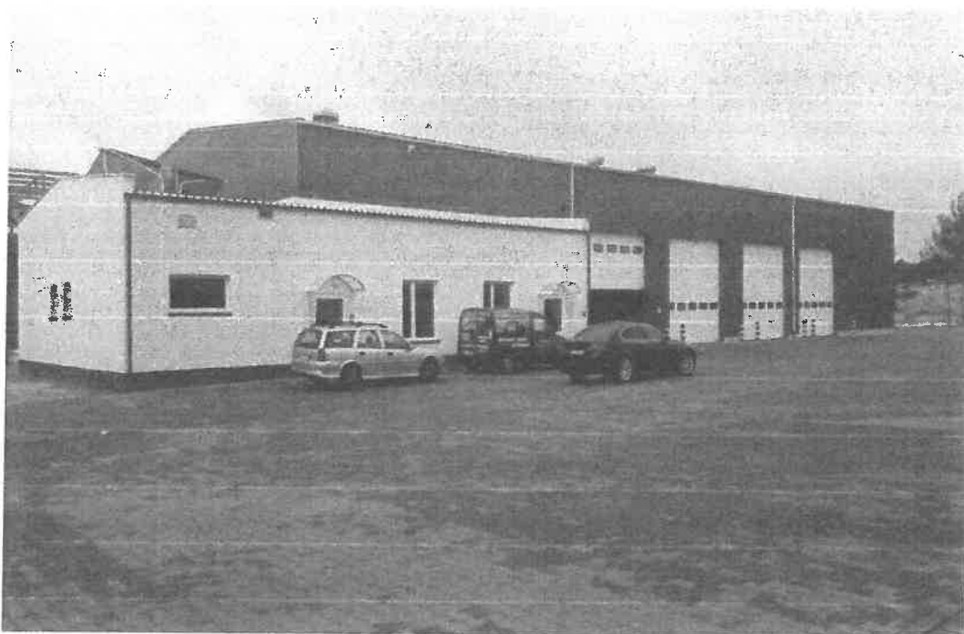
Fot. nr 8 – Hala segregacji (sortownia odpadów) – widok części socjalnej
