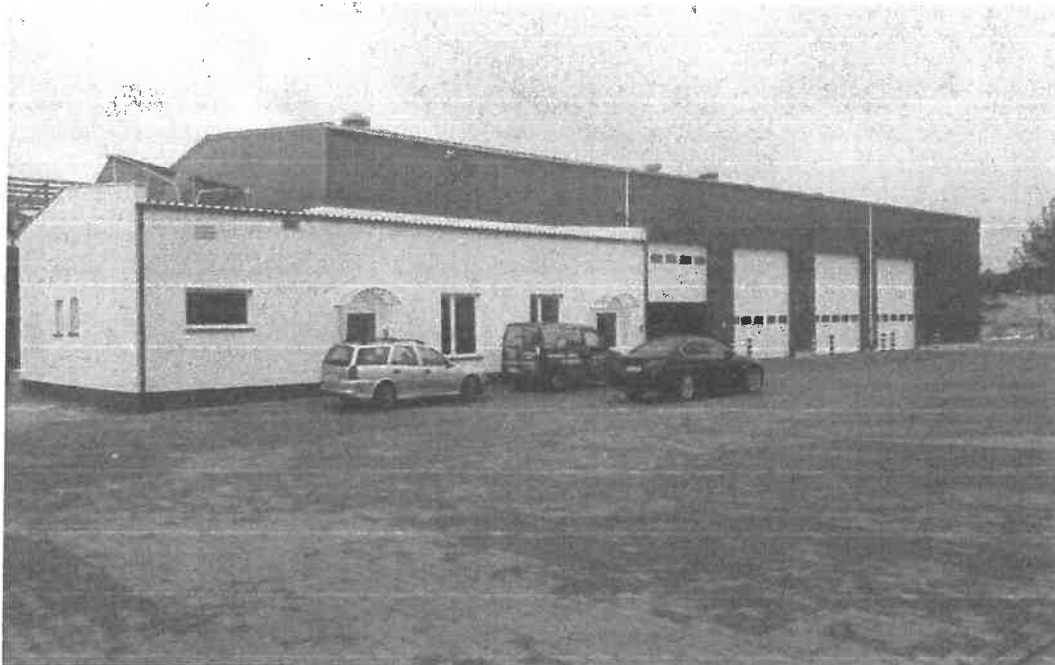
Fot. nr 4, 5 – Hala segregacji (Sortownia odpadów) z budynkiem socjalnym
