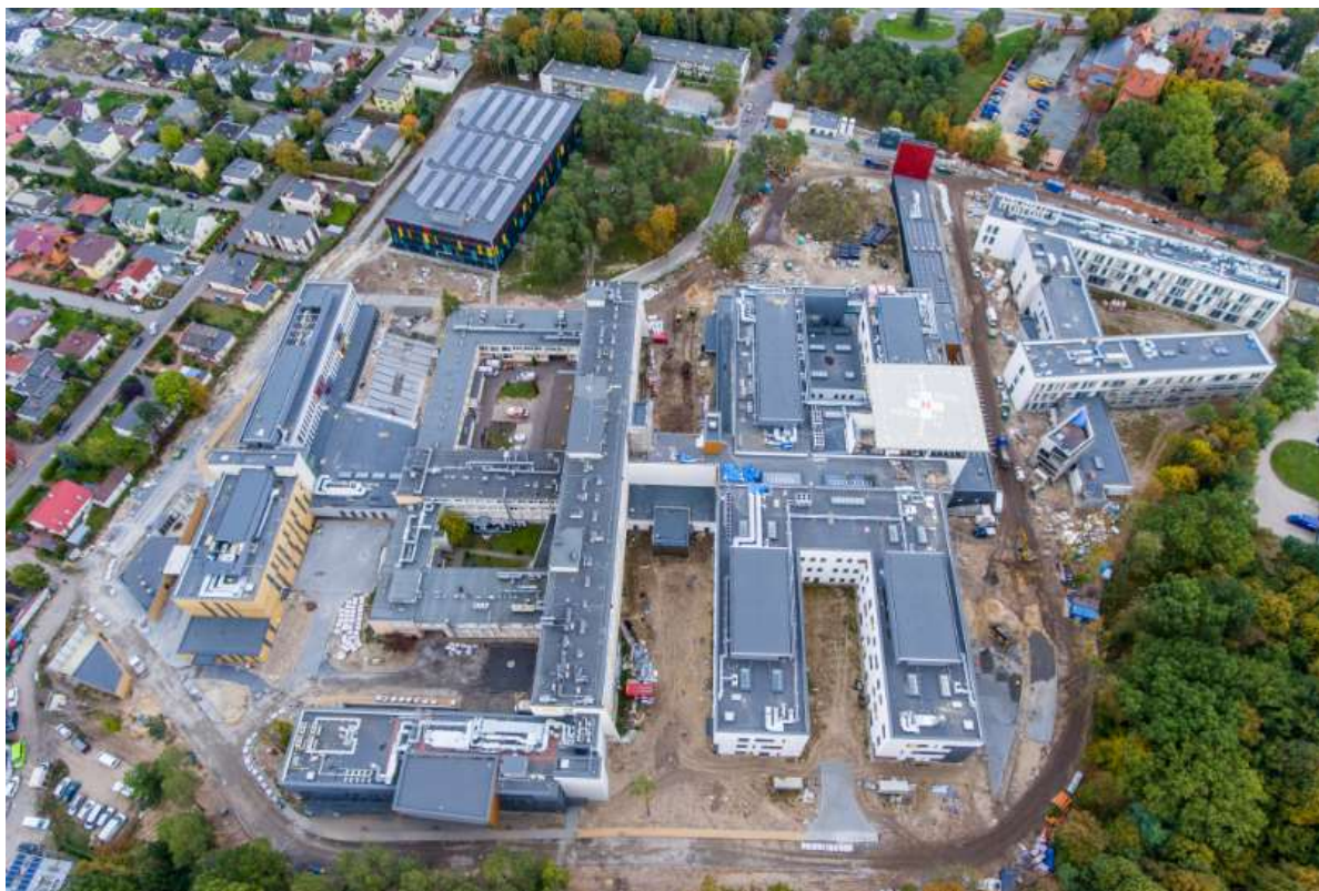
Rozbudowa Szpitala Zespołowego w Toruniu, fot. Sky Drone Studio
