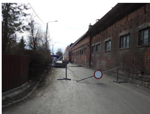
Fot. 1 - Brak wydzielenia i oznakowania strefy niebezpiecznej dla wykonywanych robót, ustawiono znak zakazu wjazdu. Fot. 2 - Zdemontowane elementy rury z nieowiniętą częścią izolacji znajdowały się poza rozłożoną folią ochronną.
