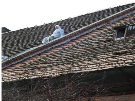
Fot. 3 i 4 - Pracownicy wykonują prace bez zabezpieczenia przed upadkiem z wysokości, bez hełmów ochronnych, masek ochronnych i okularów ochronnych.
