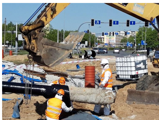
Fot. 1 - Brak wydzielenia i oznakowania strefy niebezpiecznej dla wykonywanych robót, ustawiono znak zakazu wjazdu. Fot. 2 - Zdemontowane elementy rury z nieowiniętą częścią izolacji znajdowały się poza rozłożoną folią ochronną.
