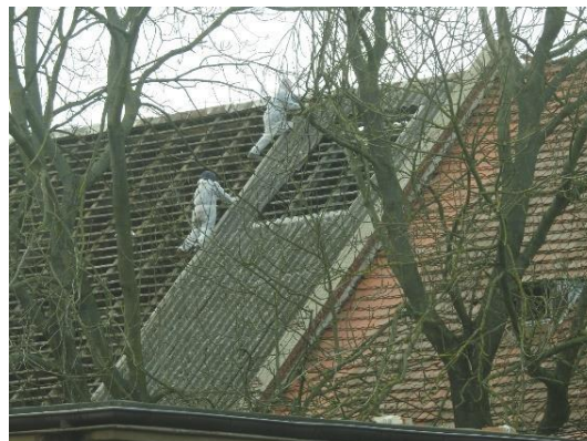
Fot. 3 i 4 - Pracownicy wykonują prace bez zabezpieczenia przed upadkiem z wysokości, bez hełmów ochronnych, masek ochronnych i okularów ochronnych.
