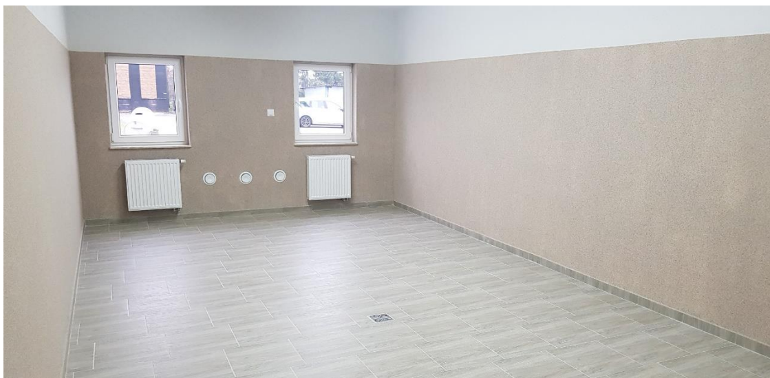
Szatnia, zaplecze socjalne, Sępólno Krajeńskie, styczeń 2020 r.
