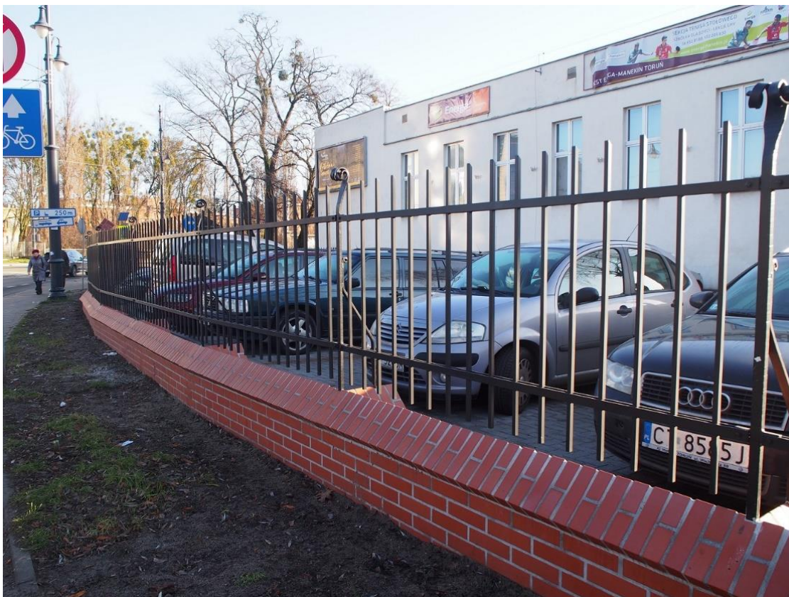
Rozbudowa ogrodzenia terenu KW PSP Toruń, ul. Prosta 32, styczeń 2020 r.
