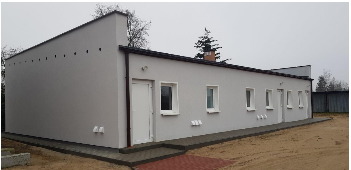
Szatnia, zaplecze socjalne, Sępólno Krajeńskie, styczeń 2020 r.
