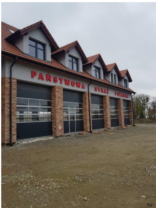
Budowa strażnicy, Świecie, grudzień 2019 r.
