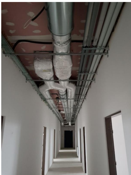
Budowa strażnicy, Świecie, grudzień 2019 r.
