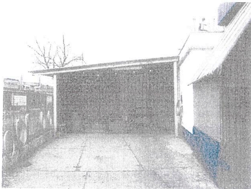
Foto 2 Budynek MO od strony Zwijaka II (strona południowa)
