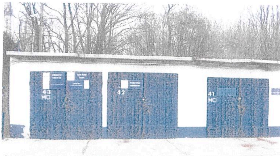
Foto 3 Budynek Garaże (nr 41-42-430)
