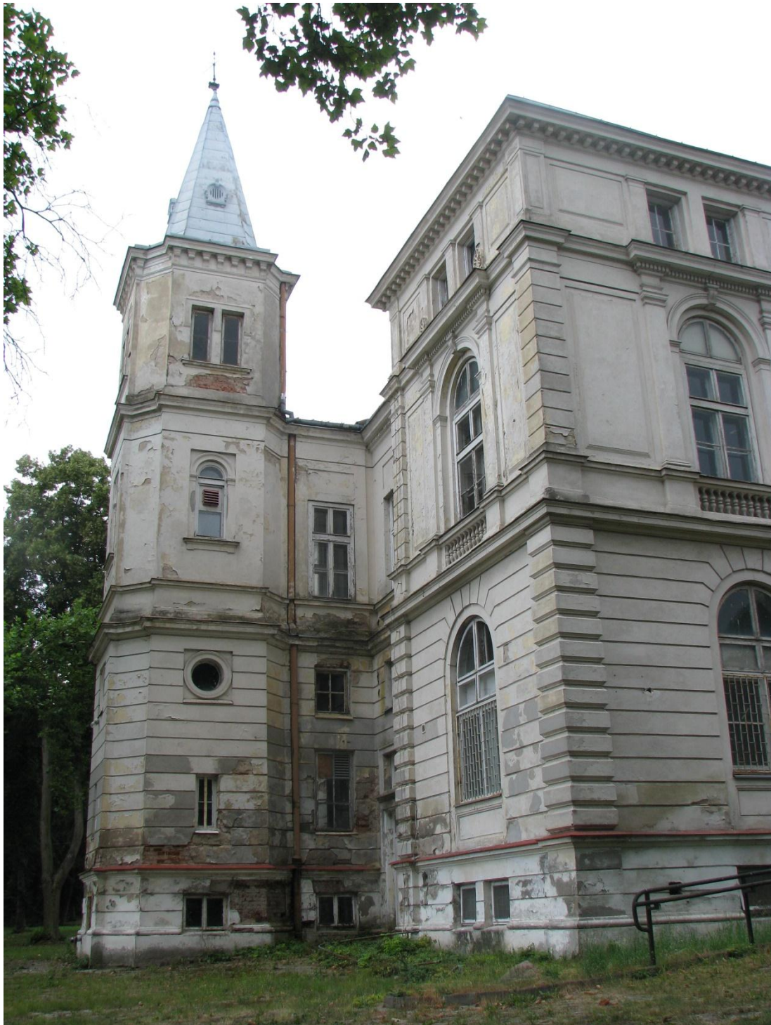
Fot. 36. Pałac Kronenbergów w Więńcu, fragmenty elewacji południowej Autor: Stefania Środa-Murawska
