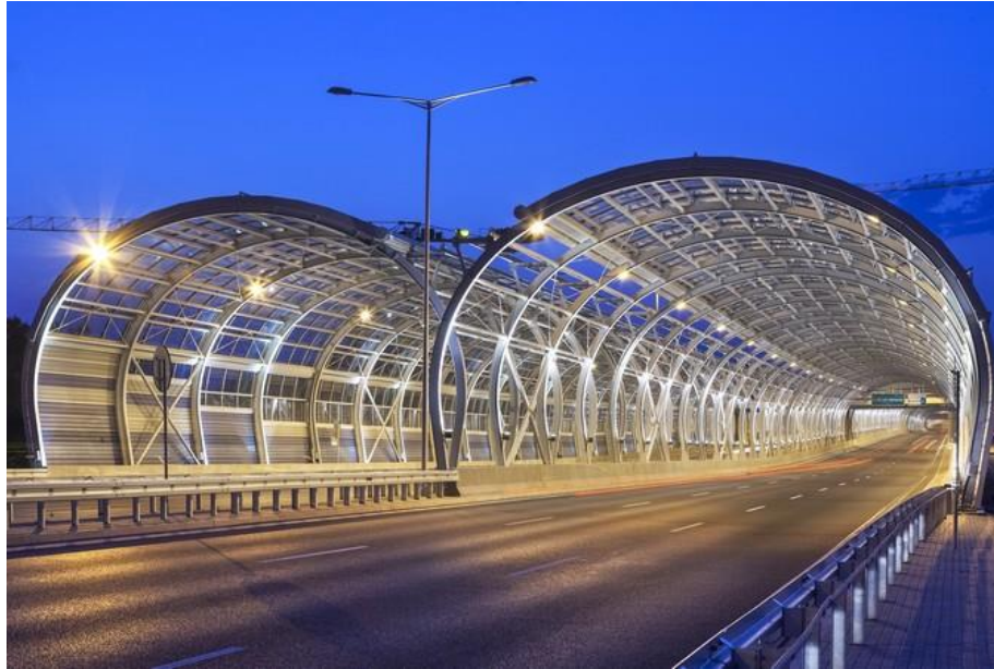
Rysunek 37. Przykładowy półtunnel akustyczny [Źródło: KÖNIG STAHL]
