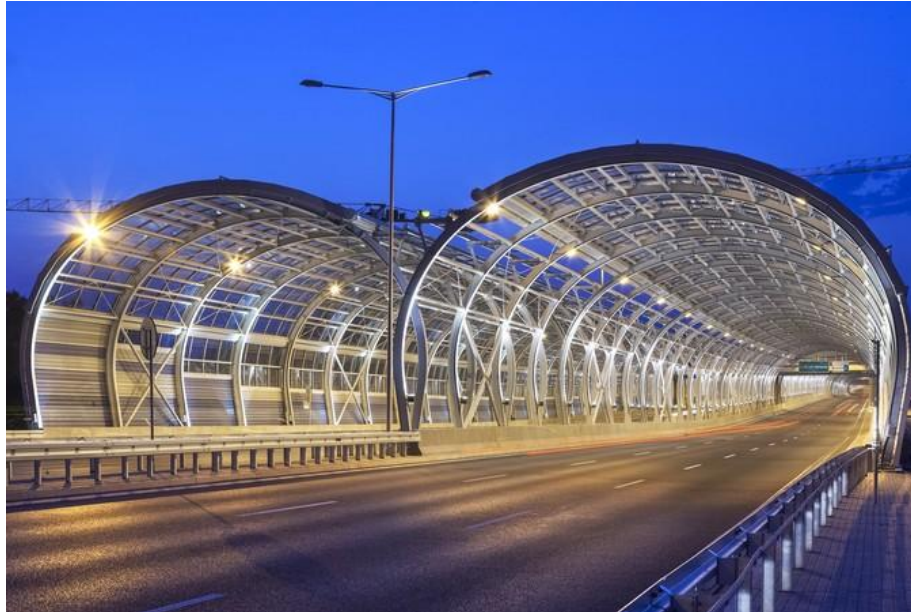
Rysunek 37. Przykładowy półtunel akustyczny [Źródło: KÖNIG STAHL]
