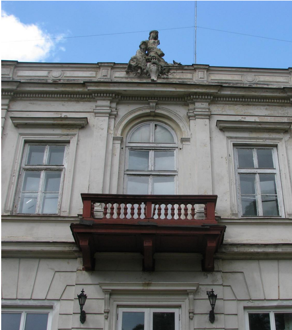
Fot. 29-32. Pałac Kronenbergów w Wiedniu, fragmenty elewacji wschodniej Autor: Stefania Środa-Murawska
