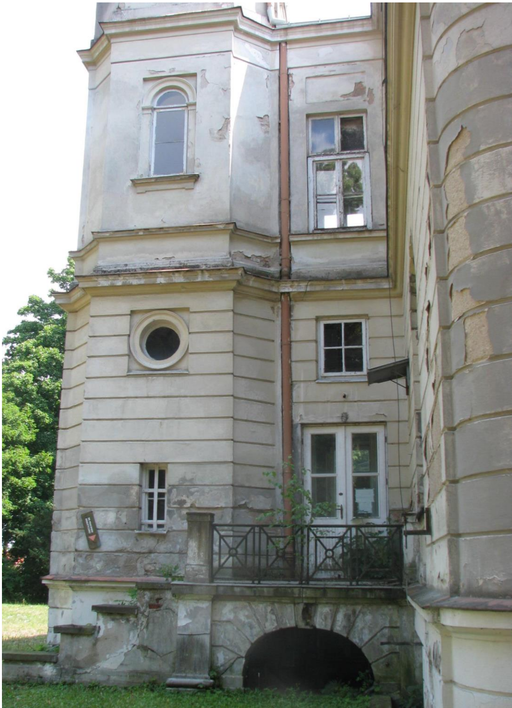
Fot. 35. Pałac Kronenbergów w Więńcu, fragment elewacji północnej Autor: Stefania Środa-Murawska
