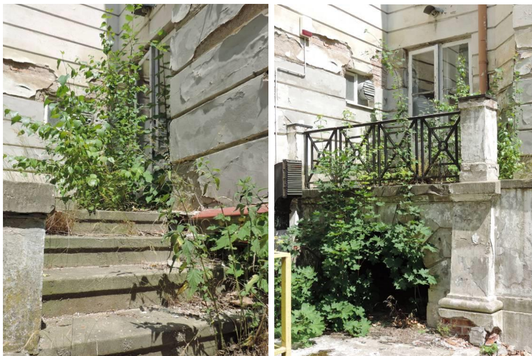
Fot. 16. Pokrywa glebowa tworząca się na budynku pałacu w Wieńcu
