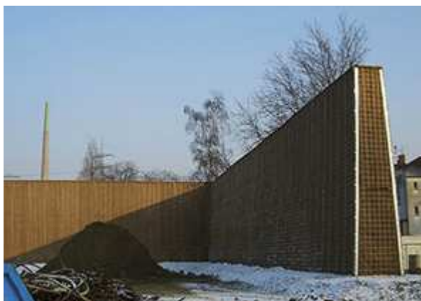
Rysunek 36. Przykładowy ekran akustyczny – ziemny ekran akustyczny z konstrukcją stalową. [Źródło: Ecotec Polska]
