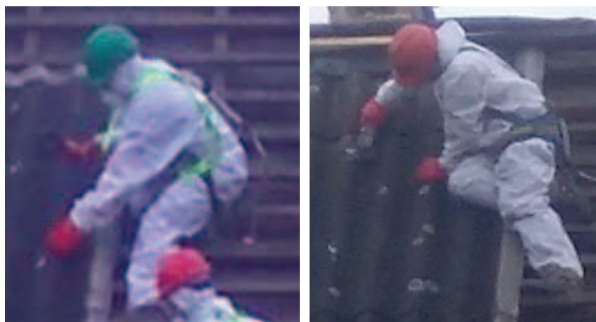
Pracownicy podczas obcinania główek gwoździ mocujących eternit za pomocą elektrycznej szlifierki kątovej na obiekcie budowlanym w Toruniu.
