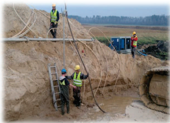
Przykład źle zorganizowanych prac ziemnych na drodze S-5 na odcinku Szubin – Jaroszewo. W wykopie o ścianach pionowych nieumocnionych i głębokości powyżej 1 metra zagłębiano igłofiltry w bezpośrednim sąsiedztwie skarpy obciążonej urobkiem i koparką.
