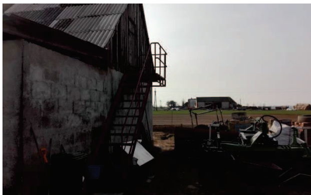
Fot. 12. Bałagan w obrębie ciągu komunikacyjnego
